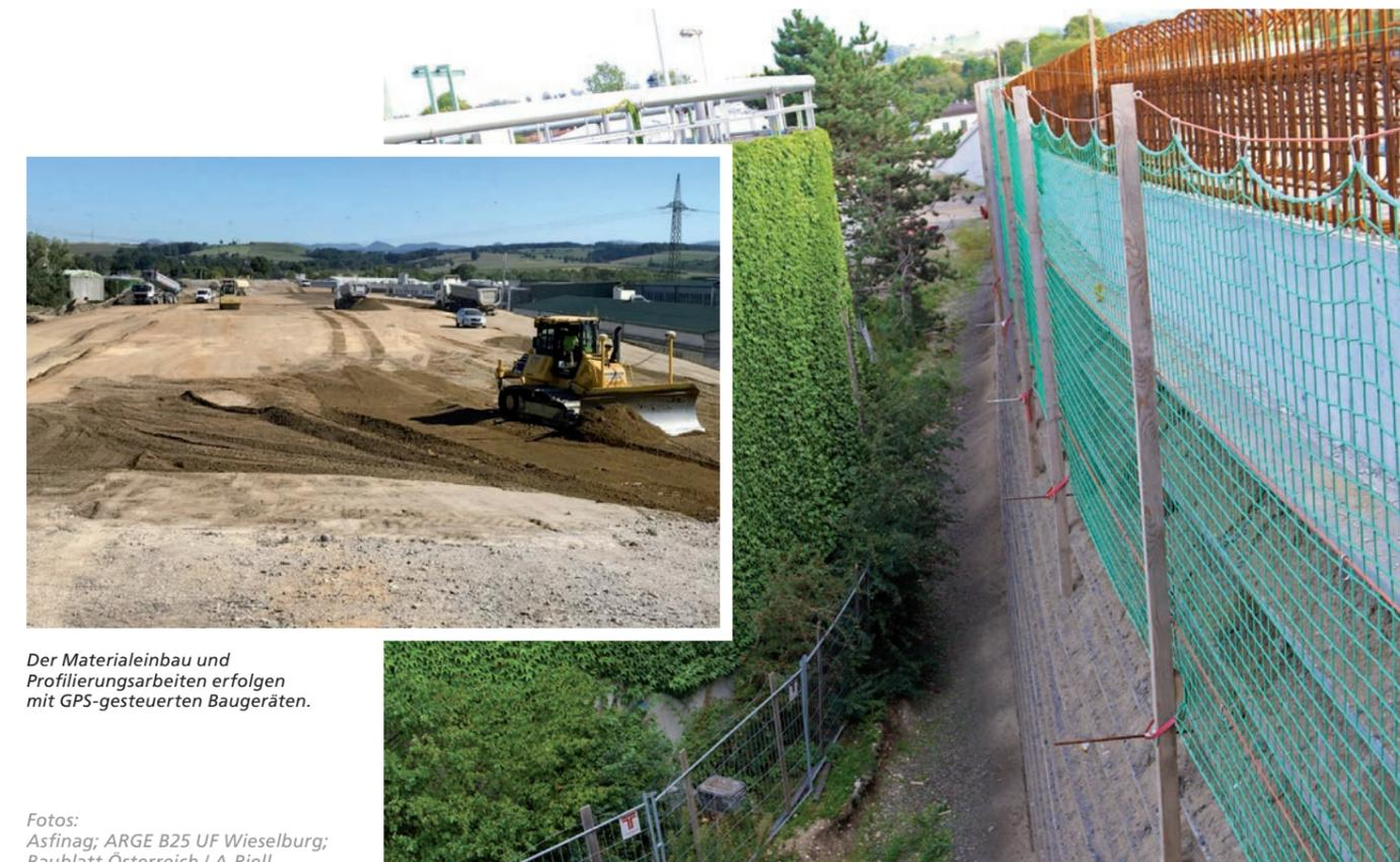
Der Materialeinbau und Profilierungsarbeiten erfolgen mit GPS-gesteuerten Baugeräten.
