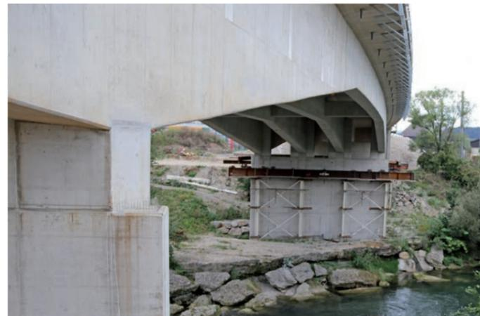
Auch die bereits fertiggestellte Erlaufbrücke Nord (Spannweite 180 m) ist als Semi-Integrales-Tragwerk ohne Lager, jedoch mit einer Fahrbahnübergangskonstruktion ausgeführt.
