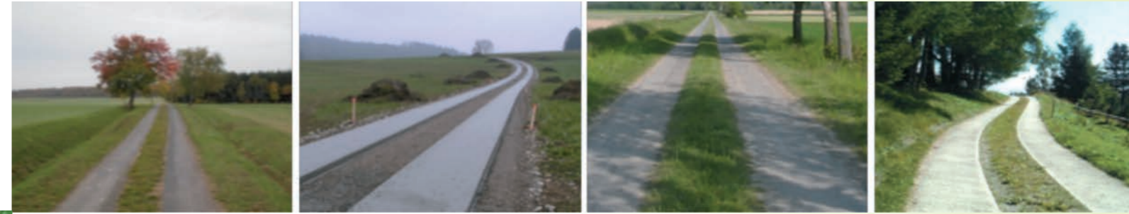
Abb. 2: Verschiedene Spurwegbautypen
