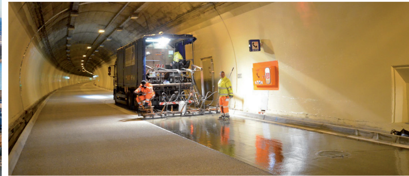
Beschichtung von Asphaltflächen: Im Rahmen der fachspezifischen Vorträge wurde auch über die maschinelle Applikation der Beschichtung (EP-Grip Belag) informiert.
