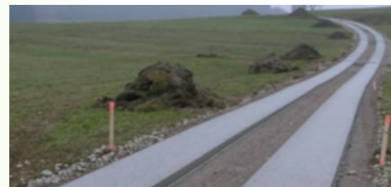
Abb. 8: Betonspurweg
