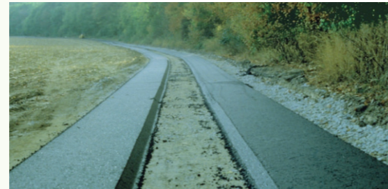
Abb. 7: Asphaltspurweg
