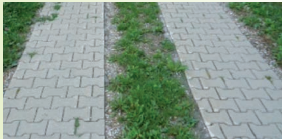
Abb.10: Pflasterspurweg
