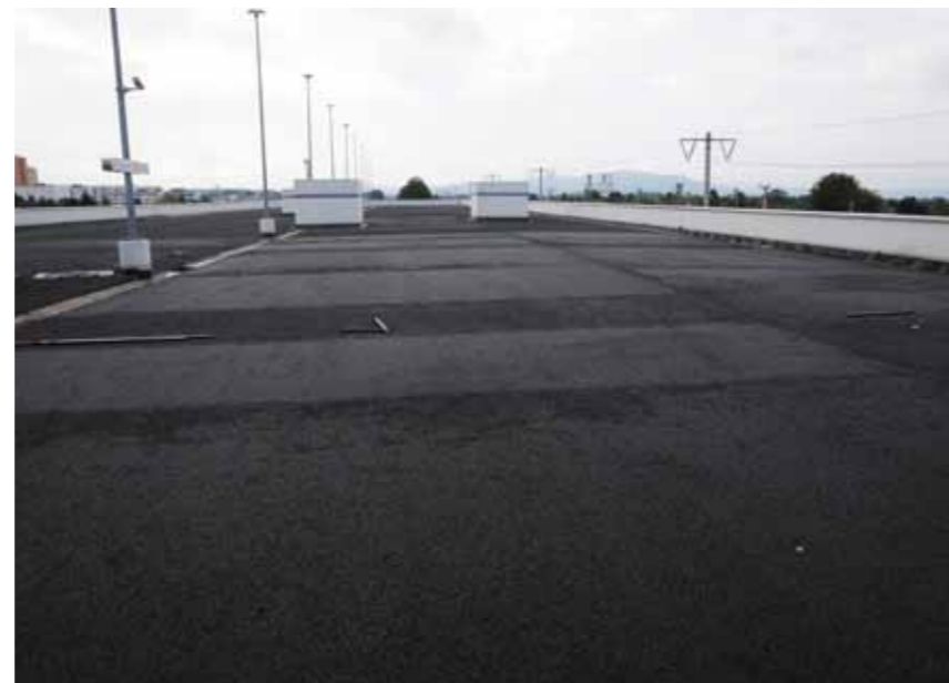
Bild oben: Massgeblich vor Ort in Wien mitorganisiert hat das IGV-Gussasphalt-Symposium die österreichische Firma und IGV-Mitglied Robert Felsing GmbH - im Bild ist die zweite besichtigte Baustelle zu sehen: ein von der Firma Robert Felsing GmbH ausgeführtes Parkdeck mit Gussasphalt als Schutz- und Deckschicht.
