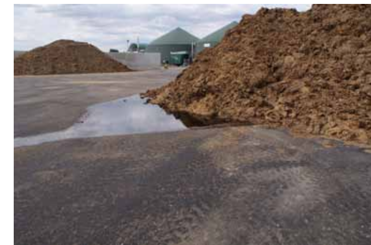
Abb. 1 Lagerfläche an einer Biogasanlage mit Silagesickersaft
