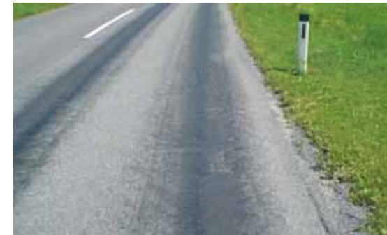
„schwitzende“ Oberfläche durch Gesteinszertrümmerung
