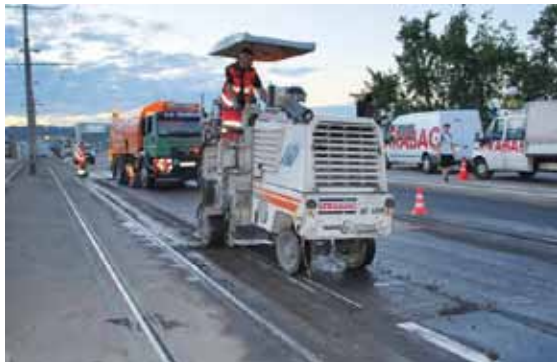
Von der Untergrundvorbereitung . . .
