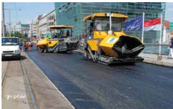
. . . bis zum Einbau der Fahrbahn-Deckschicht
