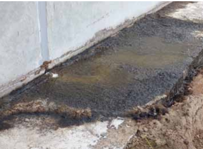
Abb. 2 Undichte Boden-Wand-Fuge
