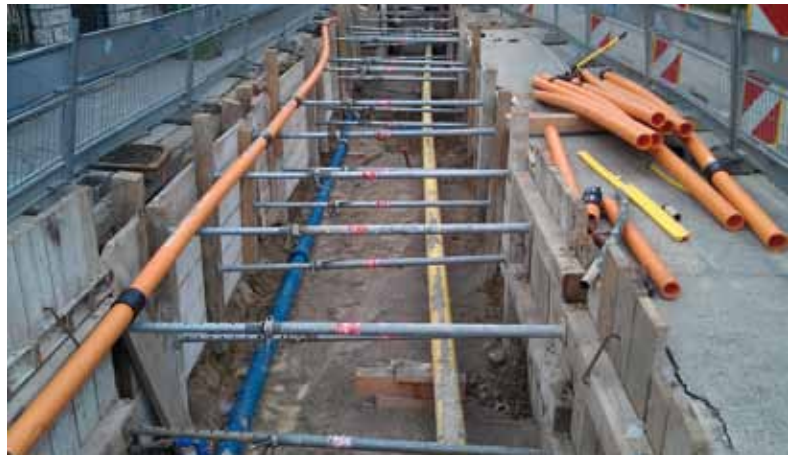
Abb. 3 Koordinierte Aufgrabung (3 Einbauten)
