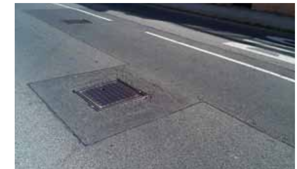
Abb. 14 Zusammengelegtes Instandsetzungsfeld
