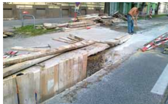
Abb. 11 Verfüllung von Hohlräumen
