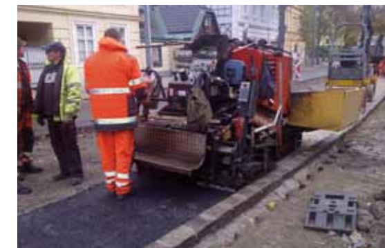
Abb. 12 Einbau mit Kleinfertiger
