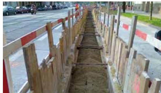
Abb.10 Korngestufte Verfüllung
