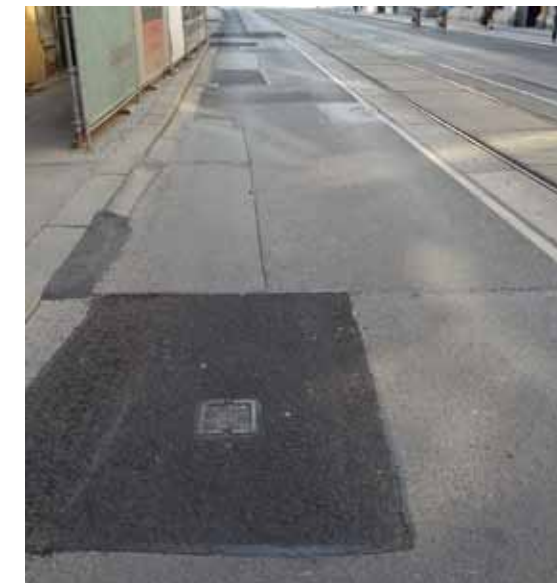
Abb. 13 Einzelne Instandsetzungsfelder
