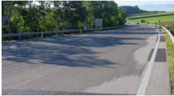
Unterlage nach Feinsichtfräsung
