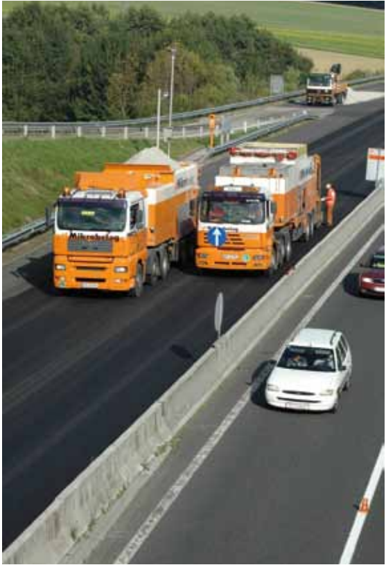
DDK Einbau auf Autobahn
