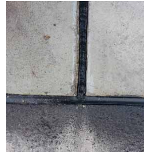
Abb. 5 Fachgerechte Verbindung der Wandfuge mit der Bodenfuge
