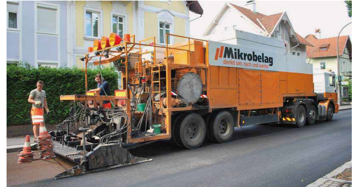
Einbau einer DDK
