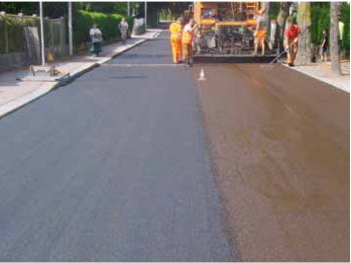
DDK Einbau im Ortsgebiet
