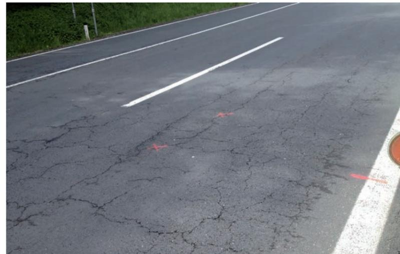
Abbildung: Eine der ausgewählten Probestrecken mit schlechter Performance schon nach 3 Jahren Liegedauer
