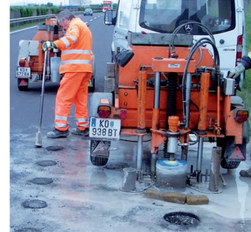
Abbildung: Bohrkernentnahme für das Forschungsprojekt
