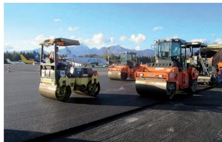
Bild 11: Einbau der Deckschicht (Flughafen Laibach)
