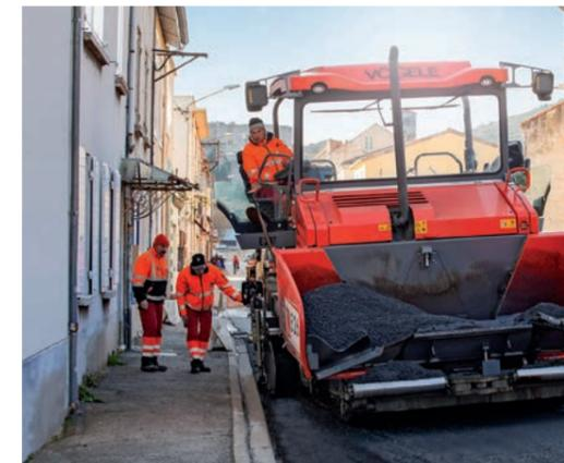
Super Flexibilität: Die Bohlenbreite kann bei Straßenverengungen oder Bürgersteigen mit einem Drehregler, dem neuen SmartWheel, stufenlos angepasst werden.
