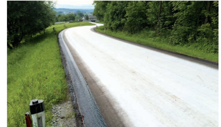
Bild 4: Faltenfrei verlegtes RVS Asphalt-Vlies
