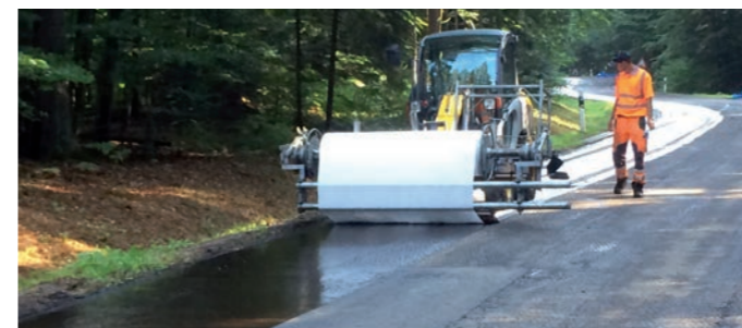
Bild 3: Verlegung von RVS Asphalt-Vlies
