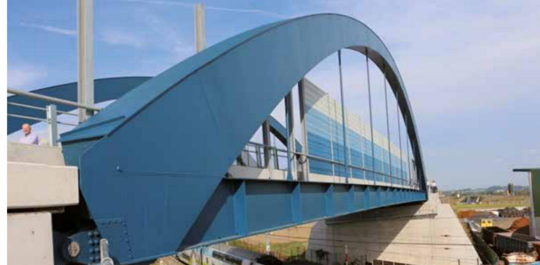
Westbahnüberführung: Das Einfeld-Stahlbogentragwerk mit orthotroper Fahrbahnplatte wurde auf der Dammschüttung südlich der Bahn vollständig zusammengebaut und in kurzen Zugspausen mit Hilfsjochen über die Westbahn längs verschoben
