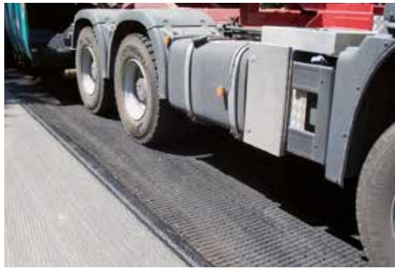
Abbildung 7: Einbau der Asphaltdeckschicht
