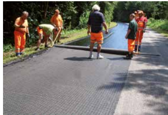
Abbildung 6: Verlegung von HaTelit
