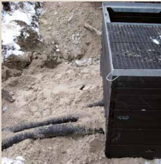
Abb. 37 Hinterfüllen
