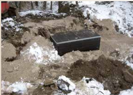
Abb. 38 Verdichteter Schacht
