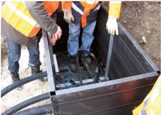
Abb. 35 Oberteil aufsetzen
