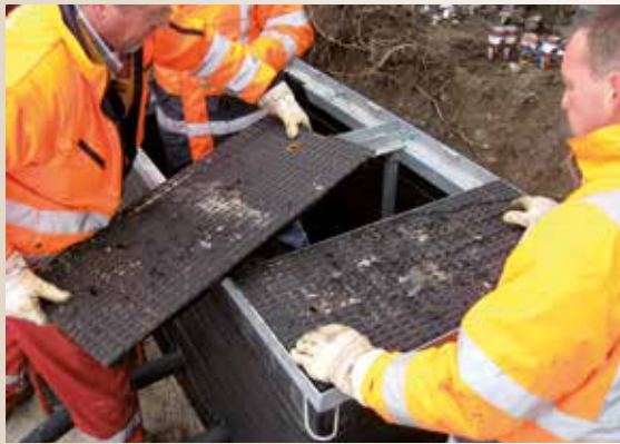
Abb. 36 Versetzen der Abdeckungen
