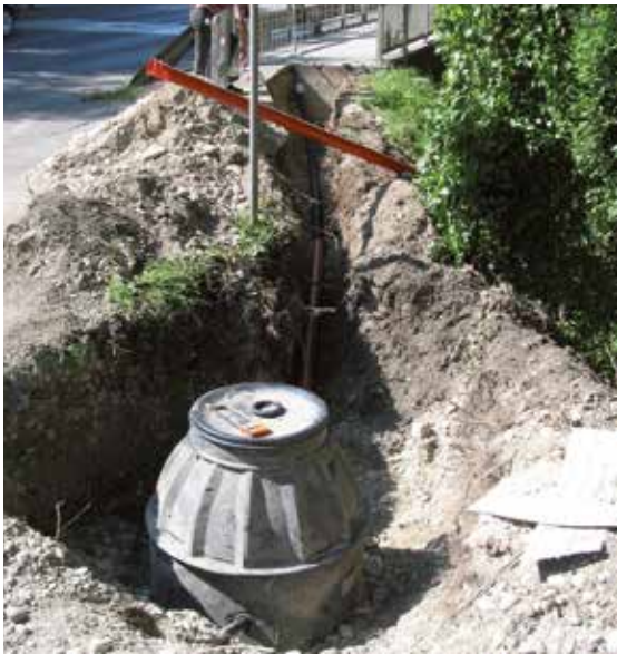
Abb. 7 Kabelschacht DN 1000, B 139
