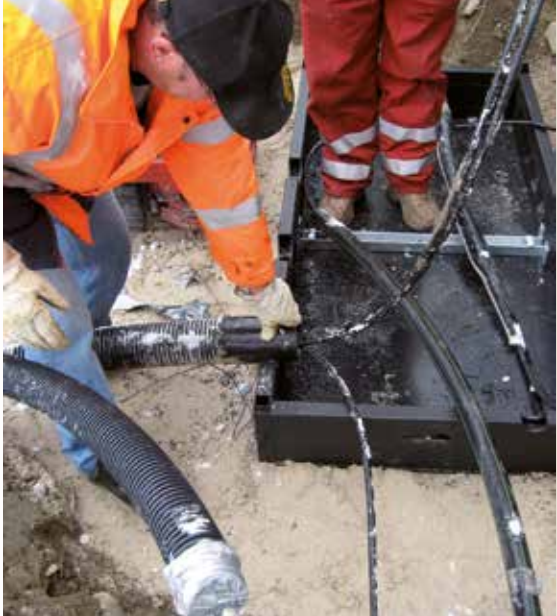
Abb. 34 Einbinden der Kabeln
