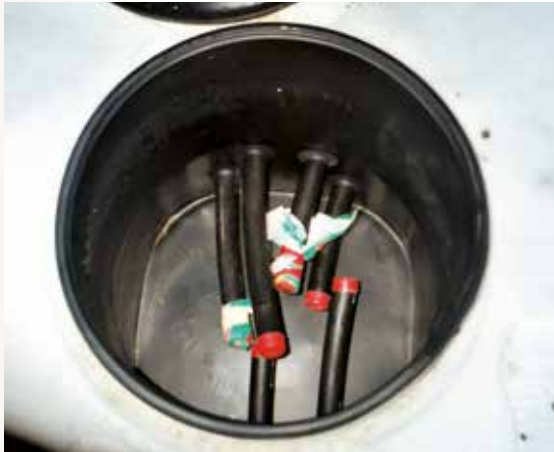
Abb. 3. Beispiel für dichten Kabelschacht runde Ausführung
