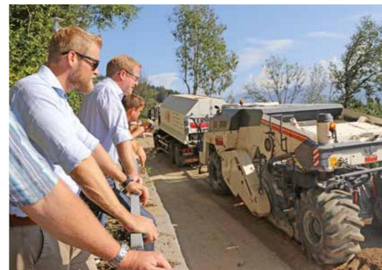
Am Beispiel der L40 Fresacher Straße wurde die „Durchfräsmethode“ vorgestellt. Der mittels Fräsrecyclings gewonnene Baustoff kann zu 100% wieder verwertet, verdichtet und mit bituminöser Tragschicht versehen werden.
