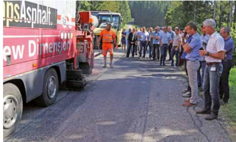
Demonstration einer wirtschaftlichen Fahrbahn-instandsetzung im Zuge der L39 Glanzer Straße. Die gezeigten Oberflächen-behandlungen sind dünne Schichten, die durch An-spritzten der Unterlage mit Bindemittel und anschlie-Bendes Abstreuen mit Edelsplitt hergestellt werden.
