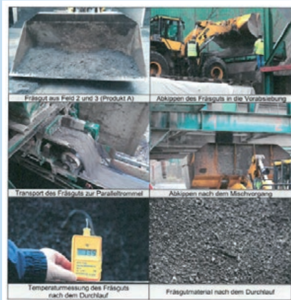
Abb. 20: Probedurchlauf in der Asphaltmischanlage
