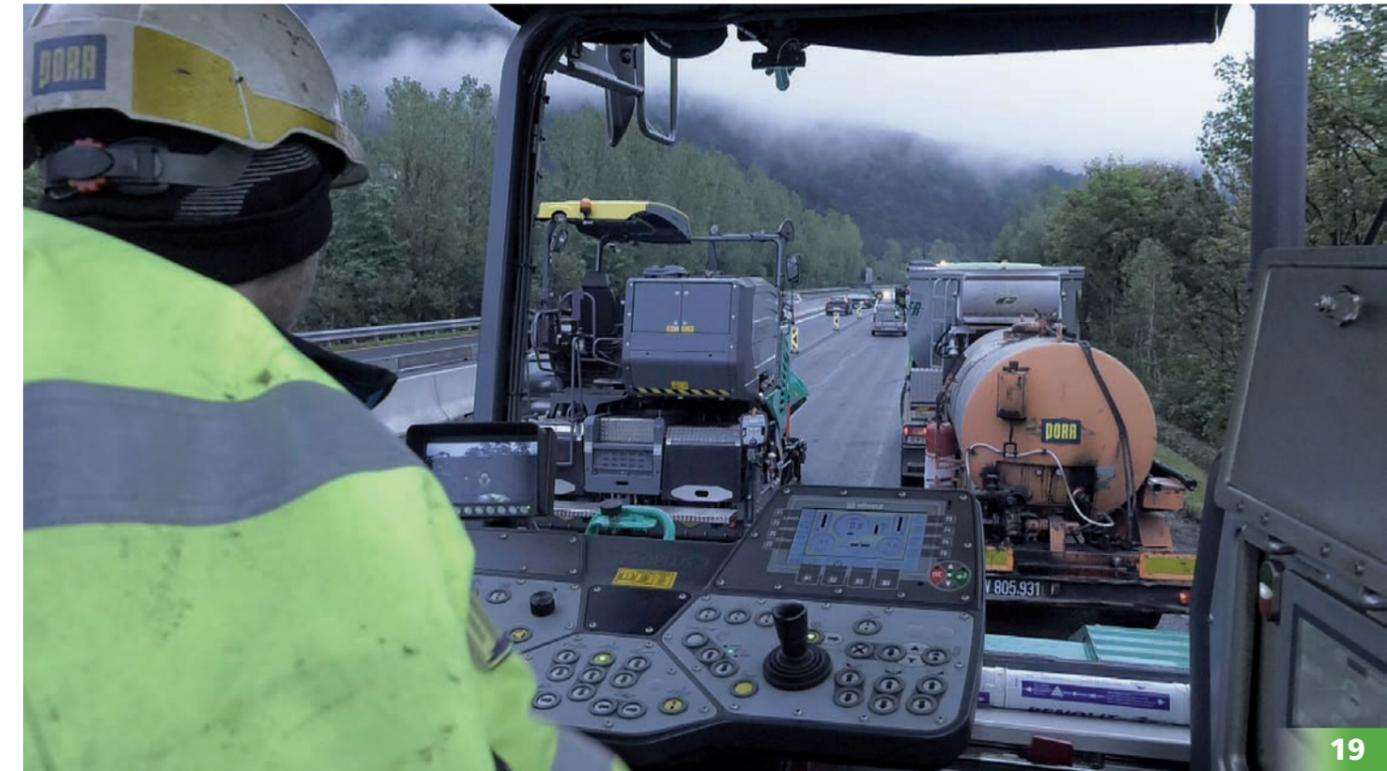
Im nachstehenden Bericht werden die gewonnenen aktuellen Erfahrungswerte bei einem abgeschlossenen Bauvorhaben unter dem Gesichtspunkt der Verwendung von Sprühfertigern und entsprechenden Verdichtungsgeräten erläutert. Diese Methode ist erstmalig auf dem hochrangigen österreichischen Straßennetz zur Anwendung gekommen.
