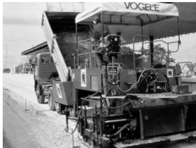
Abb. 6: Kontinuierlicher Ablauf des Einbaues
