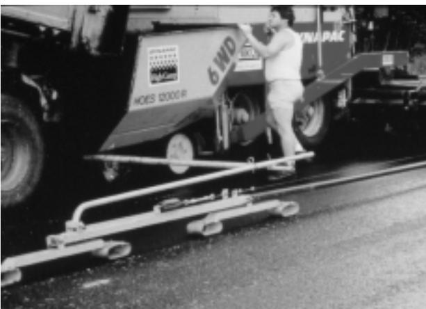
Abb. 12: Hier ein Fertiger mit einem langen Schi.
