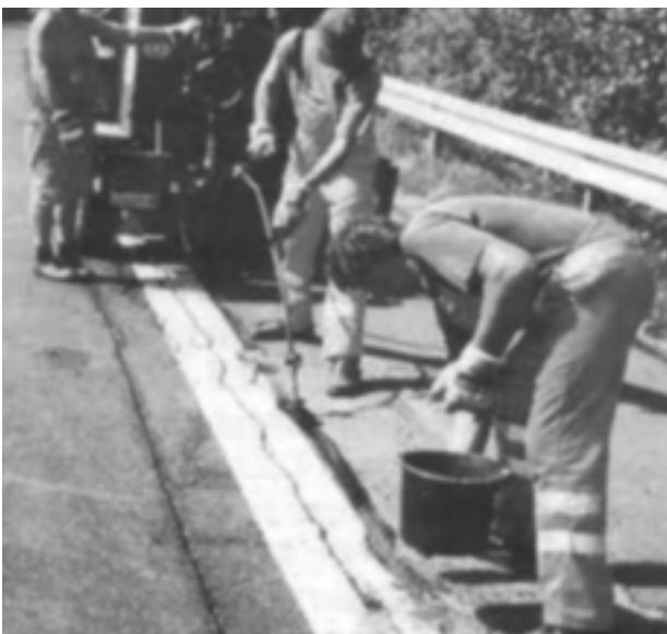
Abb. 13: Im Rahmen einer Erhaltungsmaßnahme wird ein Riss in einer Asphaltfahrbahn nach Vorbehandlung (Aufschneiden) verfüllt
