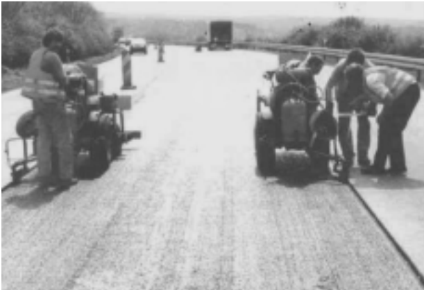
Abb. 3: Maschinelles Anbringen von Bitumen-Fugenbändern
