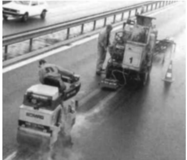
Abb. 14: Beseitigen einer schadhaften Naht mit Remixer
