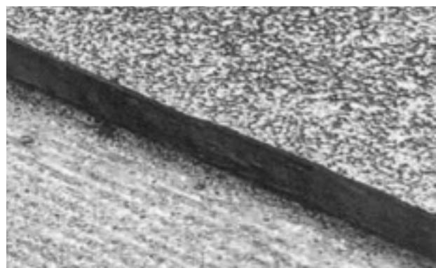
Abb 9: Appliziertes Fugenband
