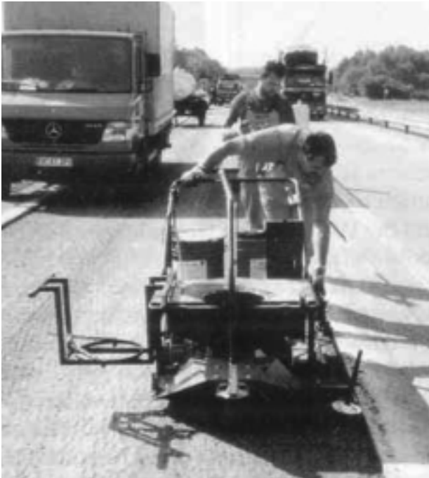
Abb. 1: Aufbringen von Kaltbitumen
