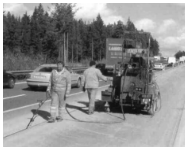
Abb. 10: Fugenverguss
