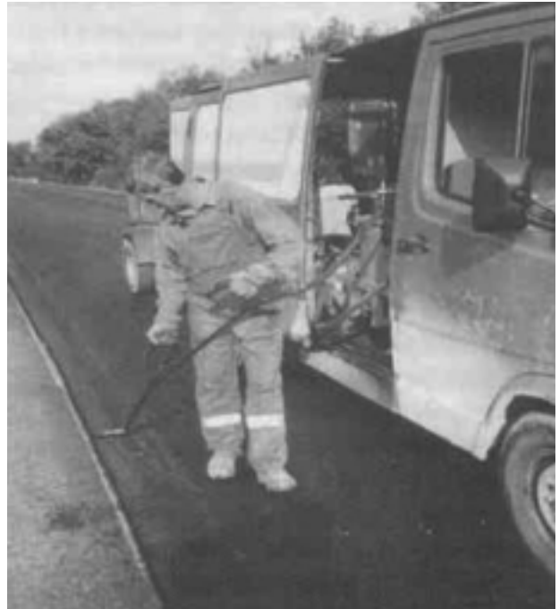
Abb. 2a: Einbau heiß verarbeitbarer Nahtkleber
