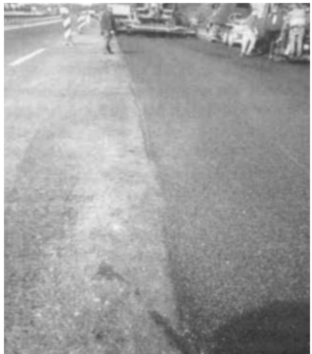
Abb. 2b: Einbau heiß verarbeitbarer Nahtkleber
