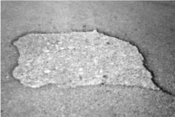
Abb. 1: Plattenförmige Schichtablösung
