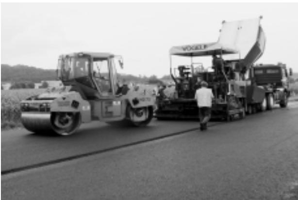
Abb. 8: Einbau und Verdichtung Gummiasphalt
