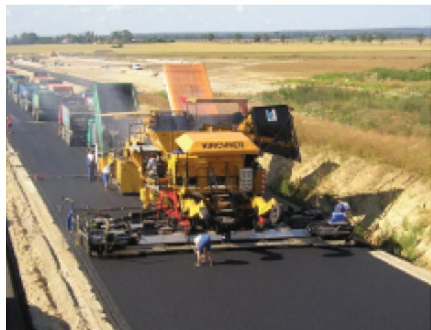
Abb. 15: Aufwendige Logistik bei der Belieferung mit zwei unterschiedlichen Asphaltmischgutsorten
