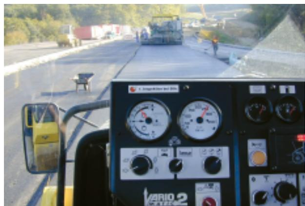
Abb. 12: Messsystem zur Erfassung der dynamischen Antwort der Unterlage
