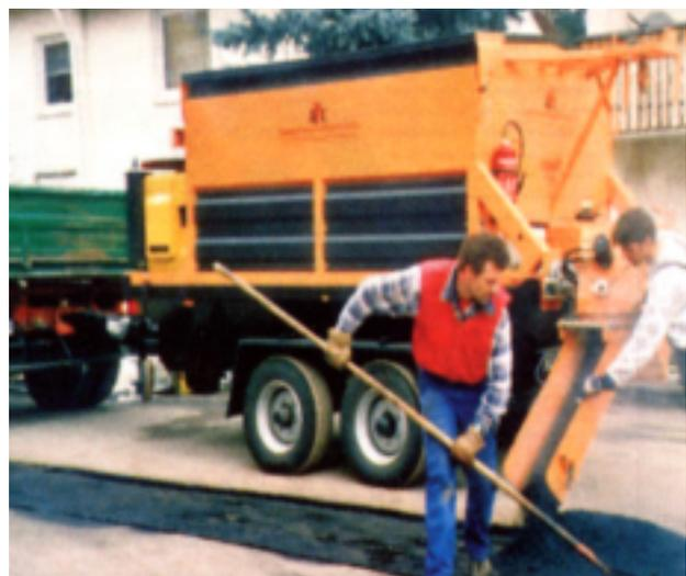
*Der Asphalt-Thermo-Container ermöglicht eine einfache Verarbeitung*
