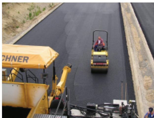
Abbildung 16: Verdichtung des Kompaktasphaltes
