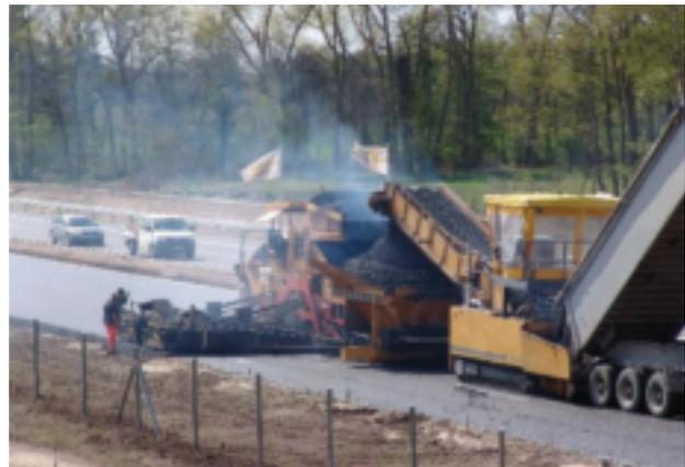
Abbildung 14: Fertiger mit zwei Einbaubohlen und Beschicker
