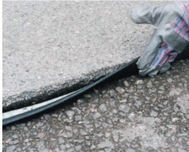
Abb. 3: Verlegung eines selbstklebenden Bitumenfugenbandes. Aufgrund der (weißen) Selbstklebeschicht braucht das Band nicht angeschmolzen zu werden.
