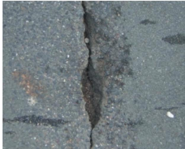
*Abb. 1: Schaden an einer Verbindungsstelle. Nach einem längerem Zeitraum entstehen Ausbrüche, da Wasser eindringt und bei Frost zu einer Sprengwirkung führt.*
