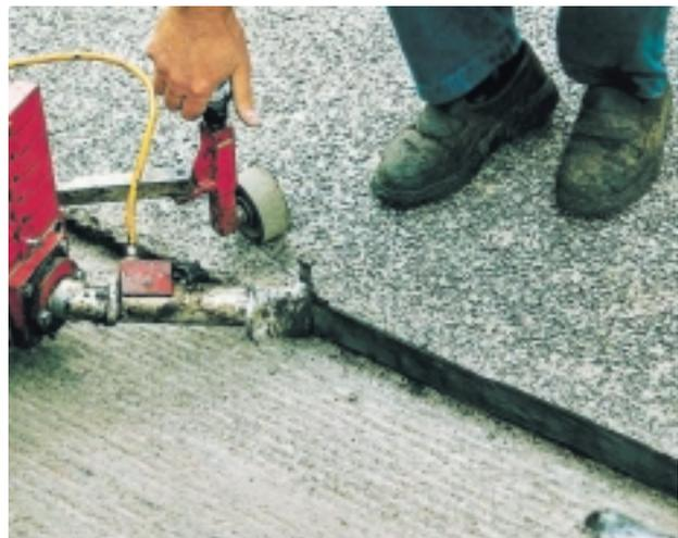
Abb. 4: Einbau eines Bitumenfugenbandes im TOKOMAT-Verfahren. Das Fugenband wird durch die Düse in der erforderlichen Höhe und Breite geformt.
