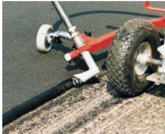
Abb. 2: Maschinelles Beschichten der Nahtflanke mit einer kaltverarbeitbaren, bitumenhaltigen Masse.
