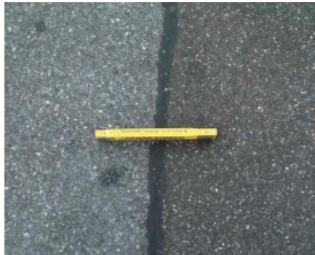
Abb. 5: Einwandfreier Anschluss, Bitumenfugenband nach mehreren Jahren Liegezeit in einer Verkehrsfläche aus Asphalt.
