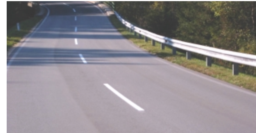
Ansicht der Deckenschichte nach einem Jahr
