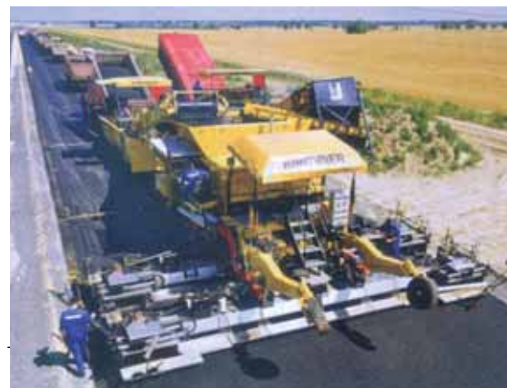
Bild 2: Einbau von Kompaktasphalt
