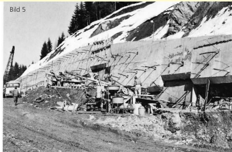
579 Bau einer 200 m langen und 15 m hohen Ankerwand in 6 Etagen »von oben nach unten« im Bau-Is 2 »Flachau«. Die 420 VSL-Anker haben eine Nennlast von 60 Mp bis 100 Mp und Längen von 26 m bis 70 m. Im Schutz der geankerten Stahlbetonplatten erfolgte der Aushub der jeweils nächsttieferen Etage. Nach dem Einbringen der Filterschichte aus Einkornbeton erfolgte das Bohren, Versetzen und Verpressen der VSL-Anker. Das Betonieren und Vorspannen der Anker schloß den Arbeitsablauf ab.
