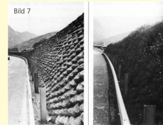
Zur Erhöhung der Verkehrssicherheit wurden 2002 bis 2004 die 1975 bis 1988 errichteten Leitschienen aus Aluminium wegen Spröbruchgefahr durch Stahlleitschienen und Betonleitwände entsprechender Rückhaltstufe ersetzt.
