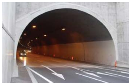
Bild 6: Betonfahrbahn im Tunnel Golovec
