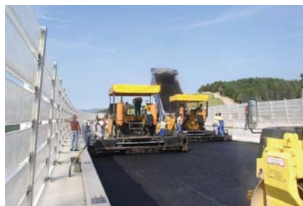
Bild 5: Einbau der Schutzschicht mit SMA 8 auf dem Talübergang Črni Kal
