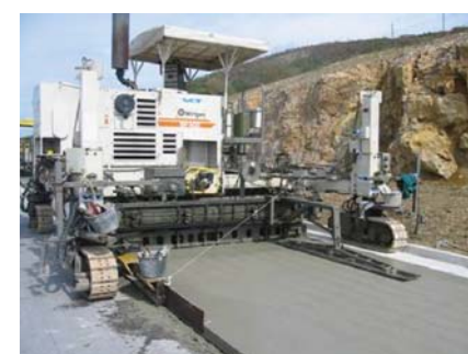
Bild 1, 2: Streifen für langsamen Verkehr auf der Autobahn Klanec – Ankaran, und Einbau
