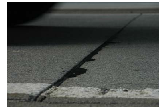
Abb. 2: Fuge auf der Betonfahrbahn der A2 zwischen Erstfeld und Amsteg. (Quelle: Basler & Hofmann)
