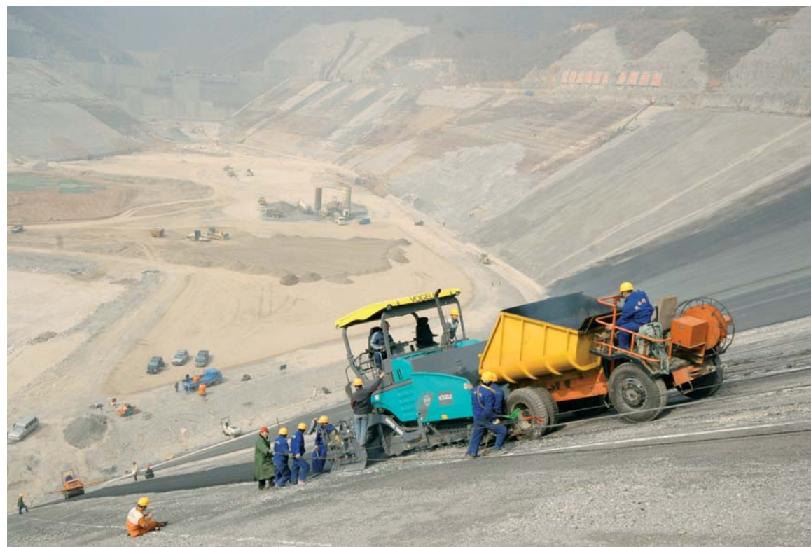
Materialversorgung unter schwierigen Bedingungen: Das spezielle Beschickungsfahrzeug ist mit einer Seilwinde gesichert Foto: Vögele AG / Mannheim
