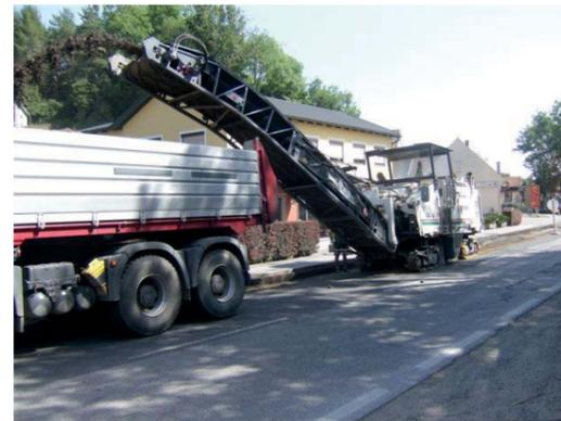
Abb. 01: Abfräsung bei einer Instandsetzungsmaßnahme
