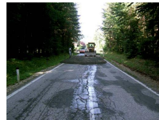
Abb. 04: Einbau mittels Grader
