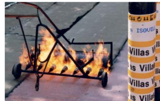
Bild 10: Flämmen mit mehrflam-migen Brenner
