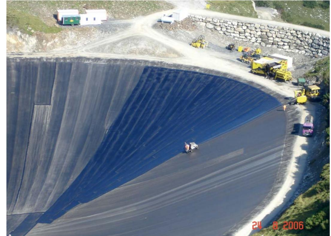
Da der eigentliche Dichtaufbau aus zwei Lagen besteht, war man beim Einbau sehr flexibel.
