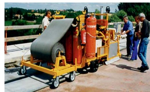
Bild 11: Maschinelles Verlegen in Großrollen gelieferter Bahnen
