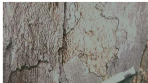
Bild 15: Einschlüsse von Blasen, die zum Zeitpunkt der Verlegung der Bahnen entstanden sind
