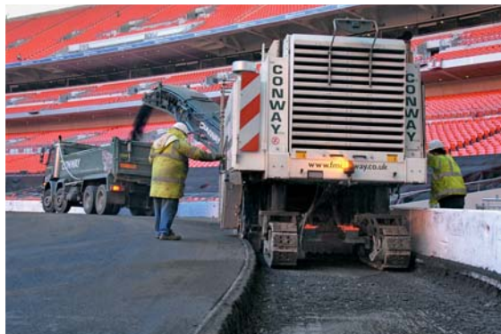
Präzises Abfräsen: In einem Maschinenübergang wurden Tragschicht und beide Binderschichten bis zu 30 cm tief ausgefräst und direkt verladen
