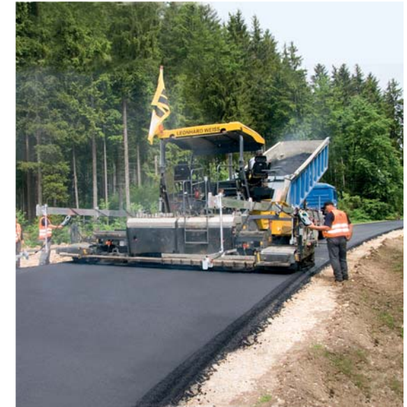
SUPER 1900-2 mit zwei Big-MultiPlex-Ski: Benutzerfreundliche Handhabung, planes Einbauergebnis.
