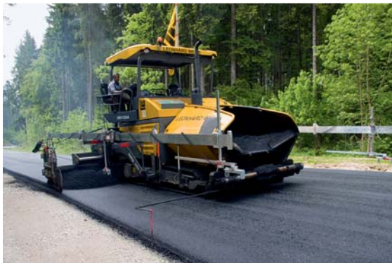
Der Big-MultiPlex-Ski zieht die Vorteile des bewährten Ultraschall-Höhenfühlers buchstäblich in die Länge: Es ist möglich, einen Bereich bis zu 13 Meter abzudecken. Damit lassen sich selbst langgestreckte Wellen spielend leicht ausgleichen.
