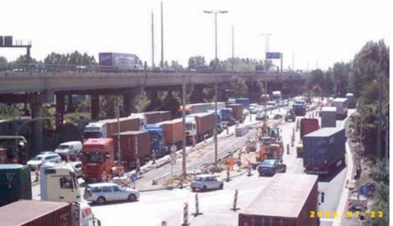
Abb. 10: Umbau unter laufendem Betrieb
