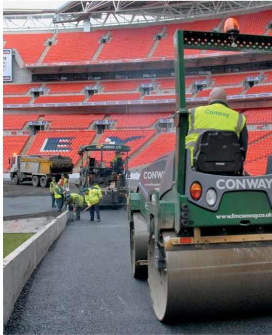
Die wendige HD 14 aus der neuen Compact-Line gab dem Rennstreckenbelag den letzten Schliff. Durch das taillierte Vorderteil der Walze hat der Fahrer eine gute Sicht nach vorne
