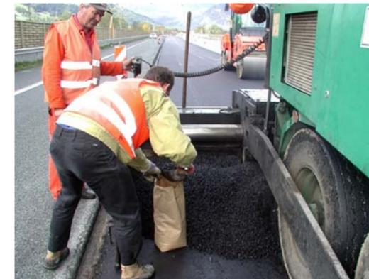
Foto 04: Probenahme im Bereich der Verteilerschnecke
