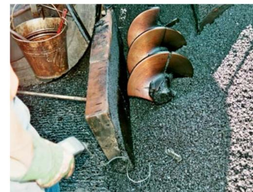
Foto 04: Probenahme im Bereich der Verteilerschnecke
