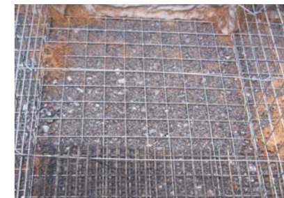
Einbindung der Geogitterbewehrung in den Gabionenkorb
