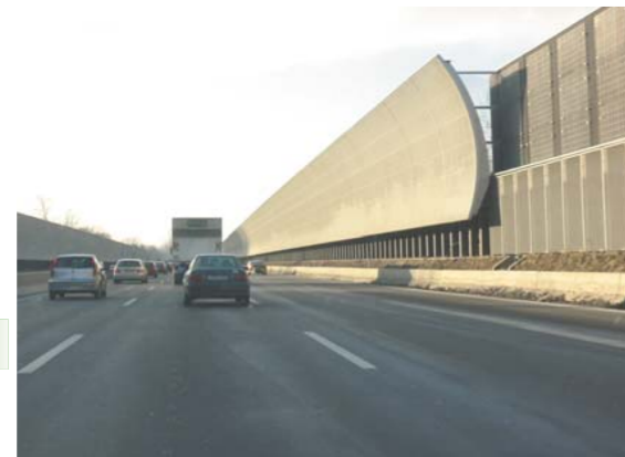
Lärmschutzwand an der A 9 in München
