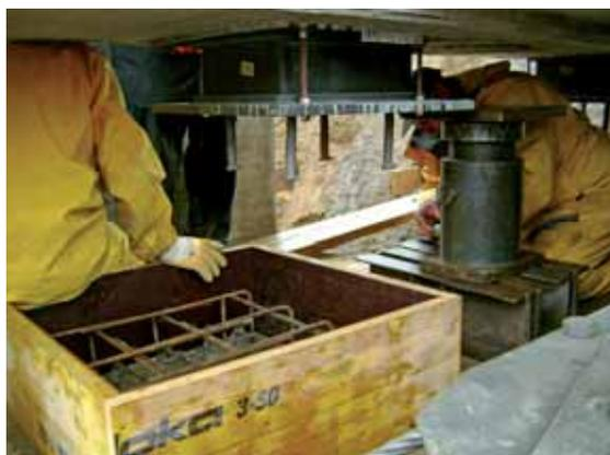
Abbildung 10: Brücke BN36.Ü03 - Absenken des Tragwerks in die vorbereiteten Auflagerbänke
