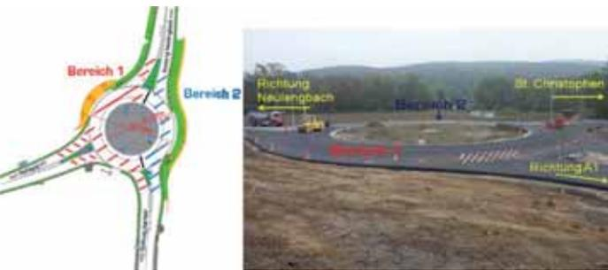
Abbildung 2: Probefeld mit Schema der Bohrkernentnahmen und ermittelte Zusammenhänge zwischen Verdichtungsgrad und Walzübergängen
