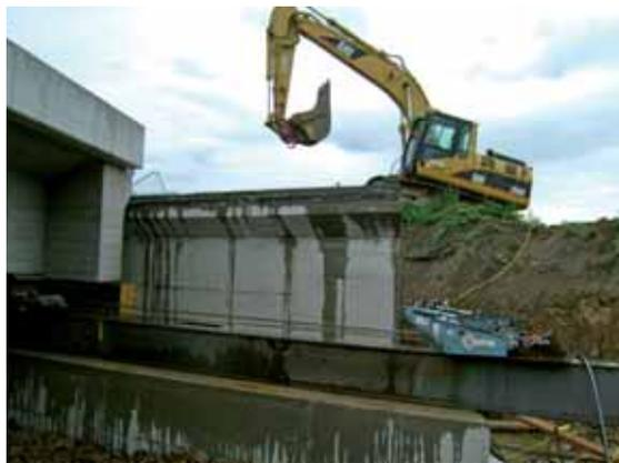
Abbildung 9: Brücke BN36.Ü03 - „Einschiebvorgang“
