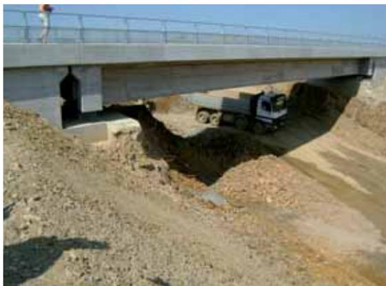
Abbildung 11: Brücke BN36.Ü03 -Aushubarbeiten unter dem eingeschobenen Tragwerk
