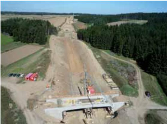
Abbildung 1: Übersicht über den südlichen Teil des Bauvorhabens (Blickrichtung Norden). Im Vordergrund eine Feldwegbrücke (LW=30 m) bei km 67,44 mit einer Breite von 15 für einen Feldweg und einen seitlichen Grünstreifen.
