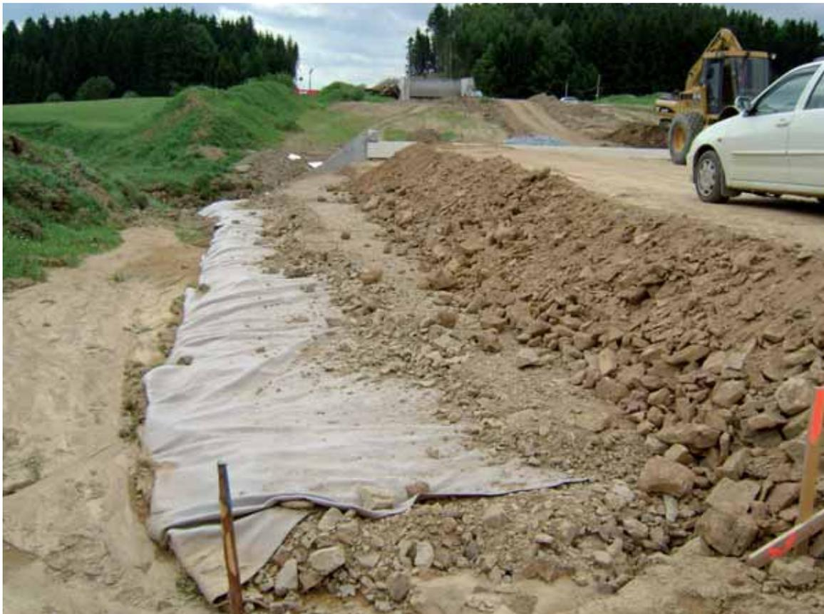
Abbildung 4: Reibungsfuß im Dammbereich von km 67,7 bis 67,8.
