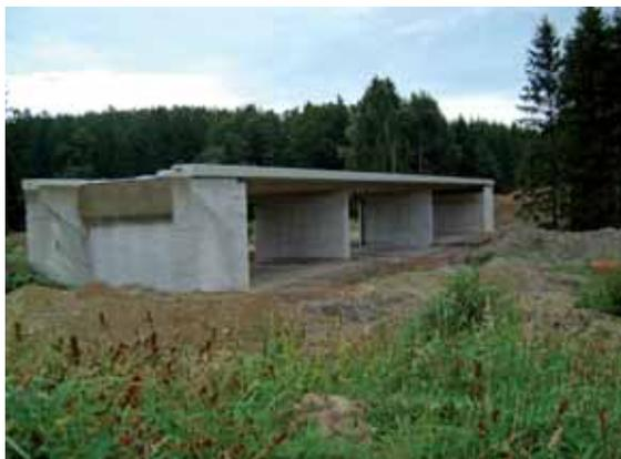
Abbildung 12: Brücke BN36.23 - Rotbachquerung mit zusätzlichen Öffnungen für den Wildwechsel
