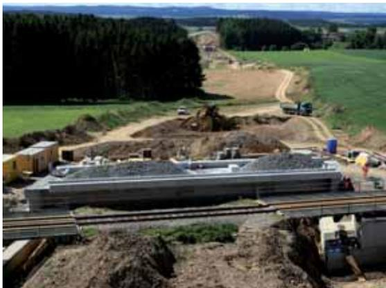
Abbildung 7: Brücke BN36.Ü03 - Im Hintergrund wird das Tragwerk für den Einschub vorbereitet. Im Vordergrund sind die beiden Behelfsbrücken zur Errichtung der definitiven Brückengründung zu sehen.
