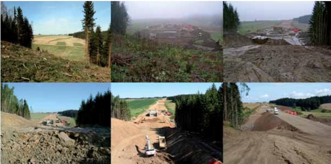
Abbildung 3: Ablauf der Erdbauarbeiten vom Baubeginn im Oktober 2008 bis zur Herstellung des etwa 10 m hohen Damms im August 2009 im Bereich von km 67,3 bis 67,8.
