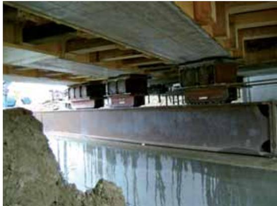
Abbildung 8: Brücke BN36.Ü03 - Fahrbahn mit Panzerwägen zum „Einschieben“ des Tragwerks
