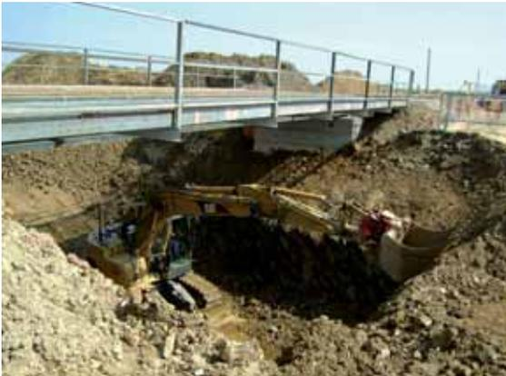
Abbildung 6: Brücke BN36.Ü03 - Aushubarbeiten für die definitive Brückengründung.
