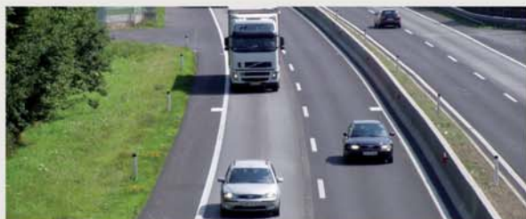
Generalsanierung der A 8 Innkreisautobahn
