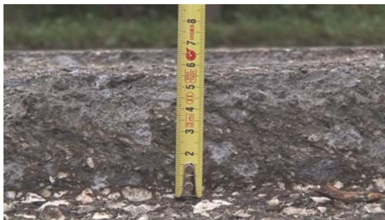
7 cm Asphalt abgefräst mit Übergriff auf Altbestand
