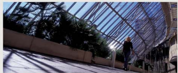
Das LKH Feldkirch wird ausgebaut
