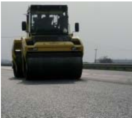
Bild 4: Intelligente Verdichtung mit BW 203 AD-AM Asphalt Manager auf Splittmastix. Der Kontrollbildschirm (BOP) zeigt EVIB-Wert, Amplitude, Geschwindigkeit und Oberflächentemperatur
