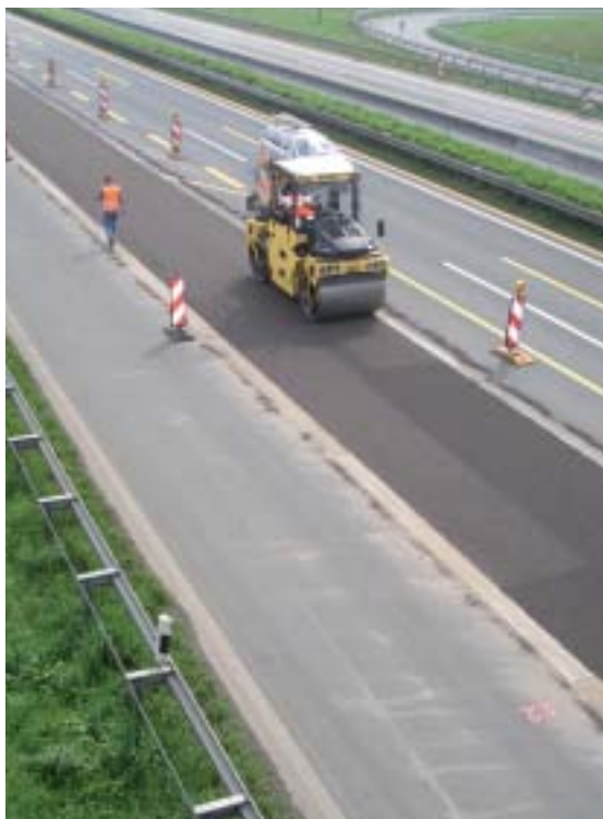
Bild 8: Verdichtung von ATS mit BW 154 AP-AM
