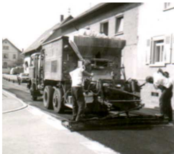
Einbau in einer deutschen Vorstadt
