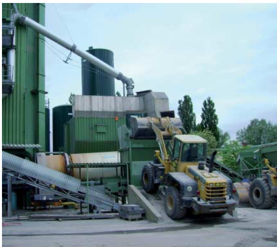
Abb. 2b Recyclingzugabe an der Mischanlage
