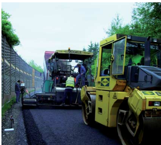
Abb. 3 Mischguteinbau AC 32 trag PmB 45/80 RC, T2, G6, RA15
