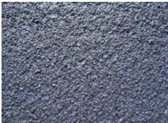
Fräsfläche nach Reinigung mit Saugkehrwagen
