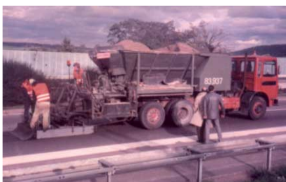
Eine Einbaumaschine in den frühen 1970er Jahren auf einer deutschen Autobahn mit dem Spurrinnenkasten
