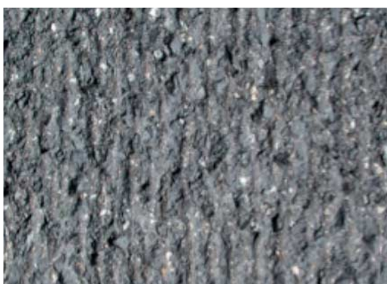
Fräsfläche nach Reinigung mit Wasserhochdruck
