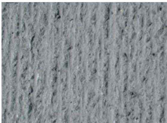
Fräsfläche nach Reinigung mit Saugkehrwagen
