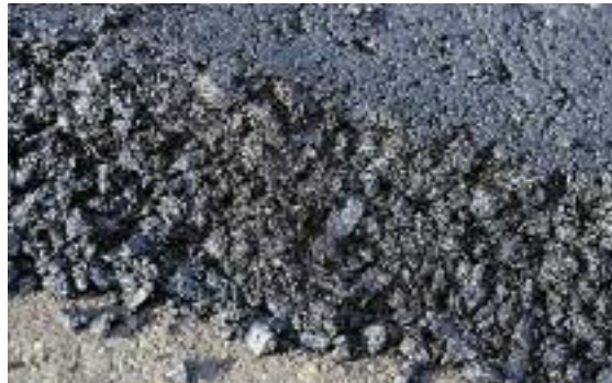
Niedertemperatur-Asphalt mit Schaumbitumen kann bei gleicher Qualität mit rund 110°C eingebaut werden.
