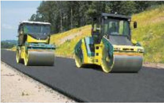
Einbau mit 110°C, Verdichtung gar mit 80°C
