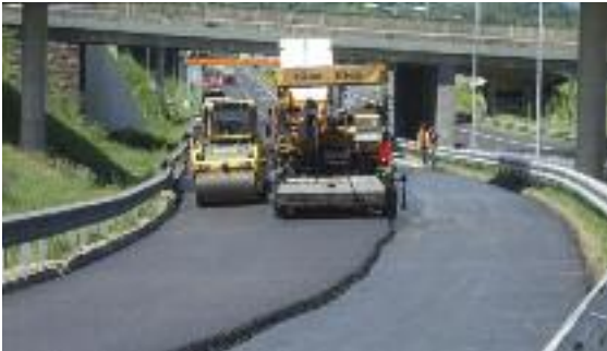
Bild 8: Einbau von Niedrigtemperaturasphalt (Quelle: Nievelt)
