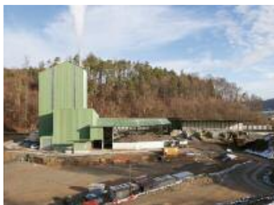
In dieser Universal NG wurden die erforderlichen 1500 Tonnen Niedertemperatur-Asphalt hergestellt.
