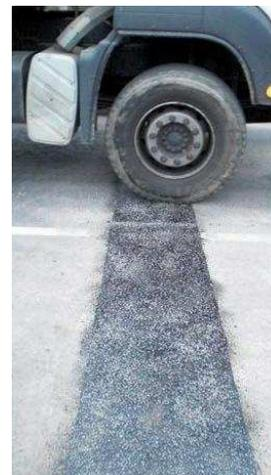
8. Einbau der zweiten Lage, absplitten und abwalzen
