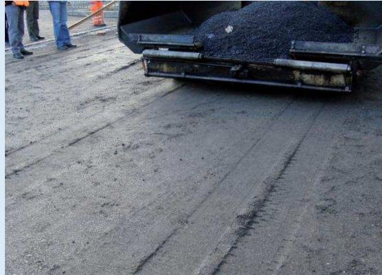
Abb. 3 Einbau auf unzureichend tragfähigem Grund: LKW-Spuren sind gut sichtbar
