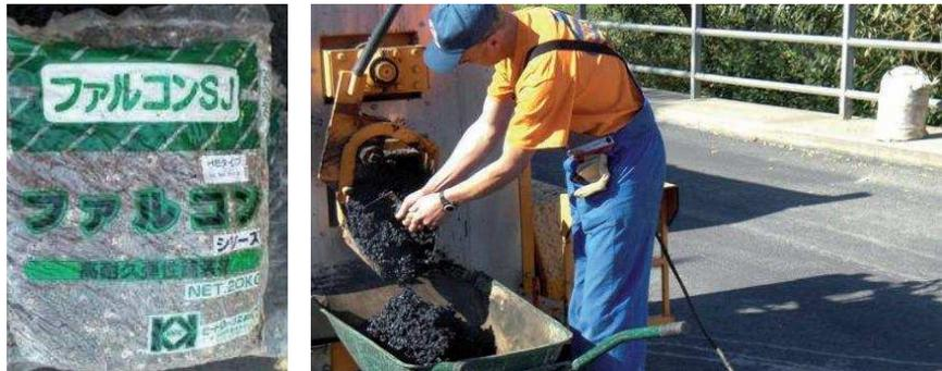
5. Vorbereiten der Falcon Masse mittels Aufheizgerät
