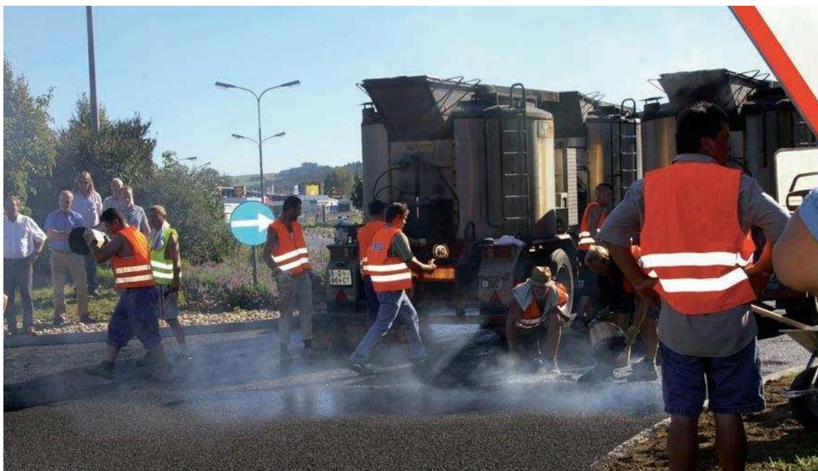
Im Kreisverkehr Hartberg wird Gussasphalt in Handarbeit eingebaut.
