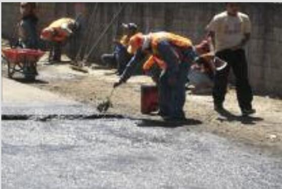
Haftkleber, Emulsion sollten genauso gewissenhaft an Anschlüssen aufgebracht werden...
