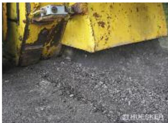
Bild 18: Fräsen der Asphaltdeckschicht inklusive der Bewehrung
