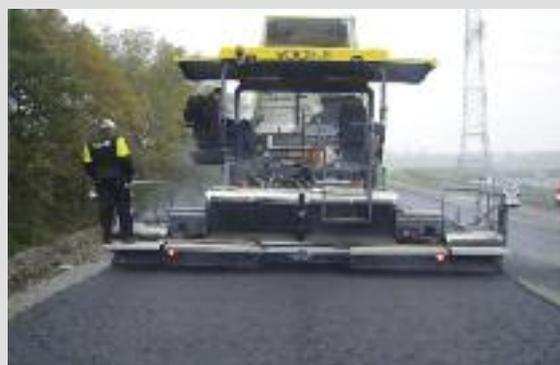
Sichtbare Entmischung wie z.B. im Mittelbereich der Bohle kann in den meisten Fällen durch Verstellung der Schneckenhöhe behoben werden. Entmischungen an anderen Stellen des Belages können andere Ursachen haben, die jedoch durch entsprechende Gegenmaßnahmen vermieden werden können.
