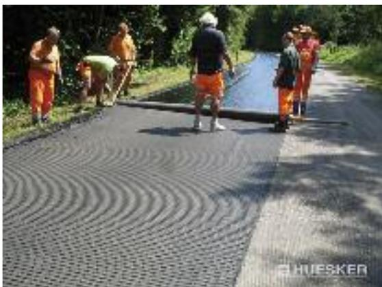
Bild 1: Verlegen einer HaTelit® Asphaltbewehrung
