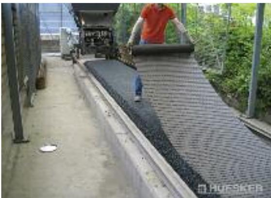
Bild 16: Verlegen der Asphaltbewehrung
