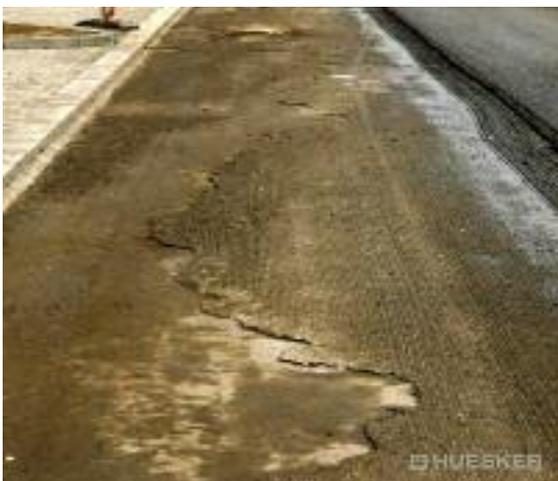
Bild 8: Rissige Binder- und Tragschicht vor der Sanierung
