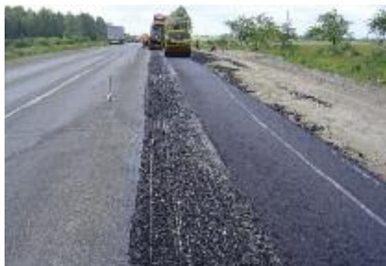
Wichtig ist die Wahl des richtigen Fertigers, z.B. die Größe abgestimmt auf die Einbauleistung. Weiters ist die Einstellung der Stampferdrehzahl und der Vibrationsfrequenz erforderlich. Da die Stampfer und Glättbleche elektrisch beheizt werden, muss auch die Bohlen-Heizung aktiviert
