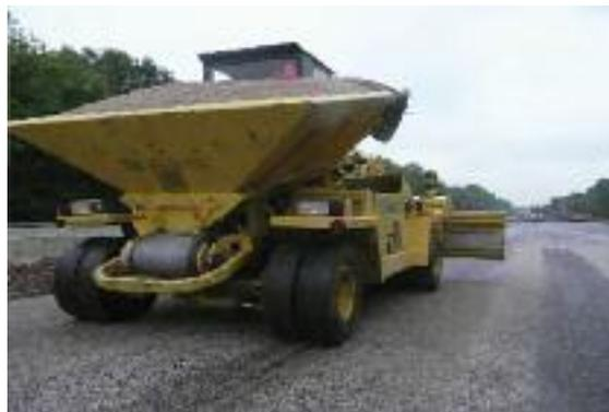
Auf diesem Bild wurde auf einer neuen Deckschicht zum Absplitten eine Maschine mit Zwillingrädern benutzt, die sehr tiefe Abdrücke im Asphalt hinterließen. Besser wäre hier eine Tandemwalze mit Splittstreuer gewesen, oder einfach weniger aufzuladen.
