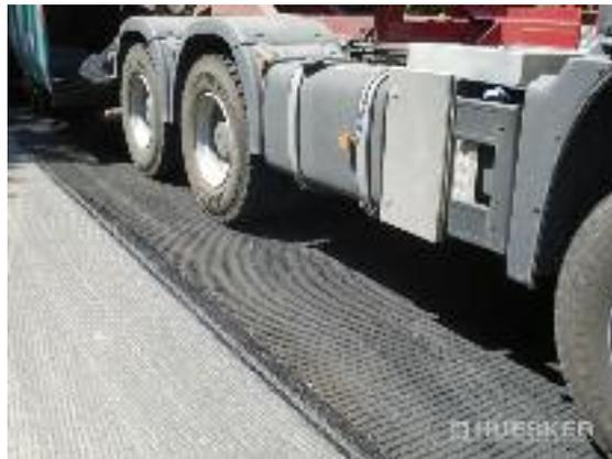
Bild 2: Überbau der Bewehrung mit einer Asphaltdeckschicht
