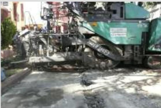
Je größer die Ungenauigkeiten in den unteren Schichten, umso größer die möglichen „Unebenheiten“ in der Deckschicht.
