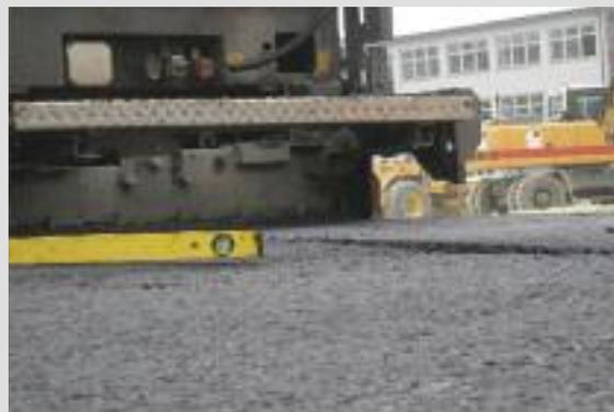
Behandeln wir nun die Phase vor dem Einbau: Die Materialübergabe muss so erfolgen, dass der Fertiger an den LKW ran fährt und nicht umgekehrt, um Stöße und damit Abdrücke in der Oberfläche zu vermeiden.
