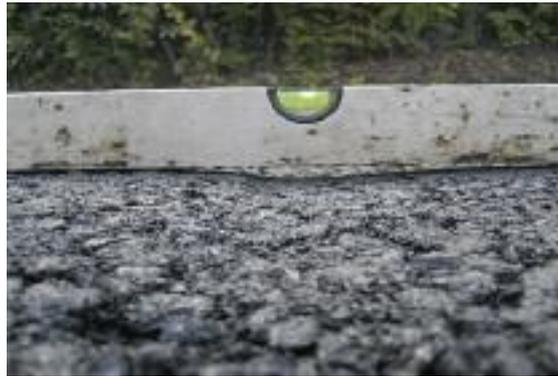
Hier hat eine Walze zu lange auf einer frischen Asphaltsschicht gestopt und eine Vertiefung hinterlassen.
