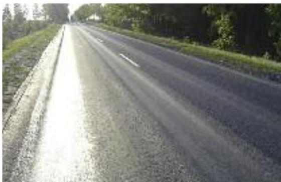
Alle aufgetragenen Schichten müssen die vorgegebenen Verdichtungswerte erreichen, bevor die jeweils nächste Lage eingebaut wird. Und dies beginnend beim Unterbau!
