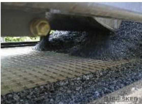
Bild 17: Einbau der Asphaltdeckschicht auf die Asphaltbewehrung
