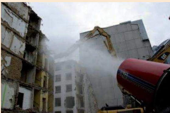
Abbildung 1: Staubbekämpfung bei Abbruch (Quelle Firma IAG Produkt ESM150 Staubbindemaschine www.iag.at )
