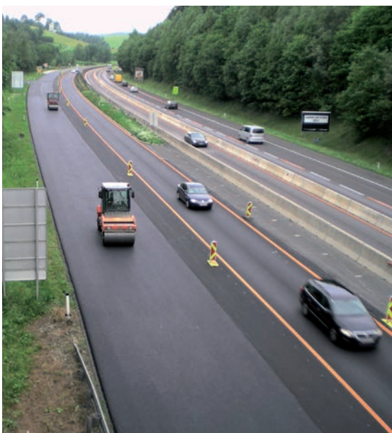
Einbau RFB Voralpenkreuz
