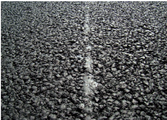
Längsnaht mit Voranstrich
