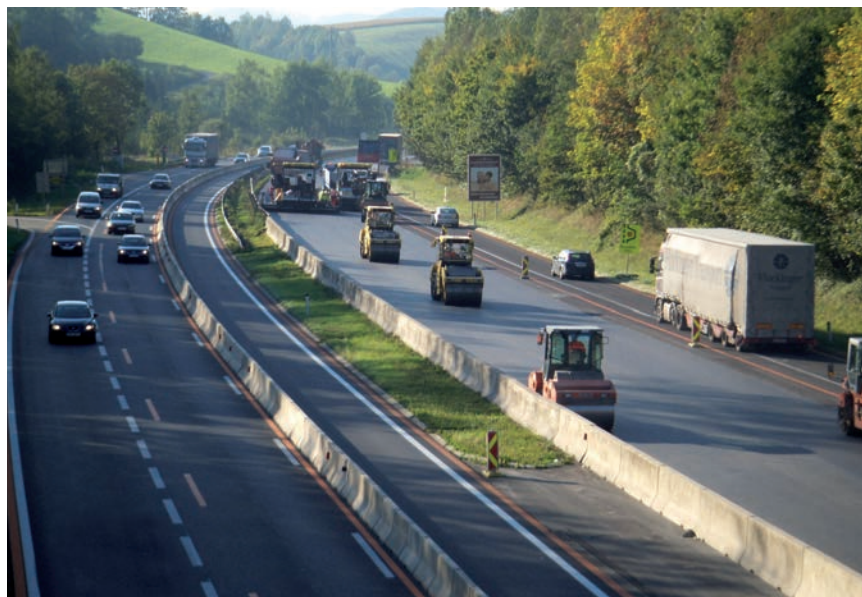
Einbau RFB Suben
