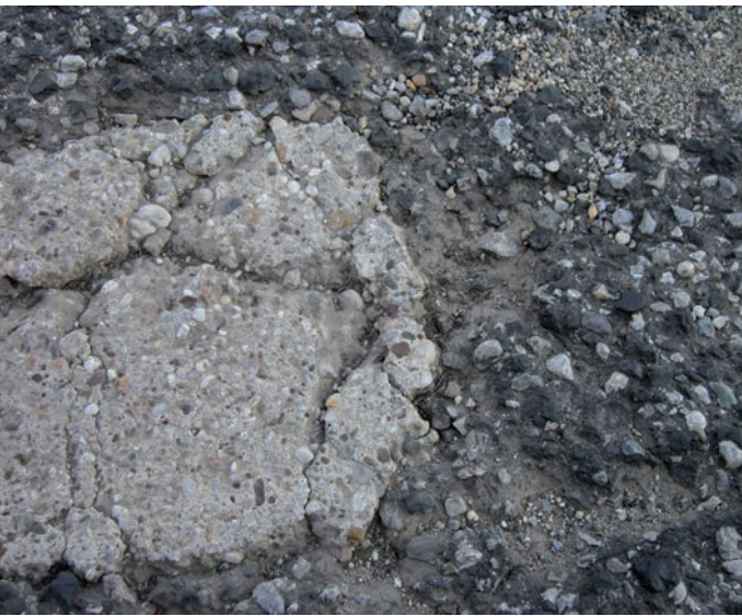
Ineffiziente Schlaglochsicherung
