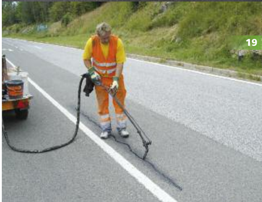
Abb. 3+4: Selbstfahrende Arbeitsmaschine (Rissefräse)/Verfüllen von Rissen
