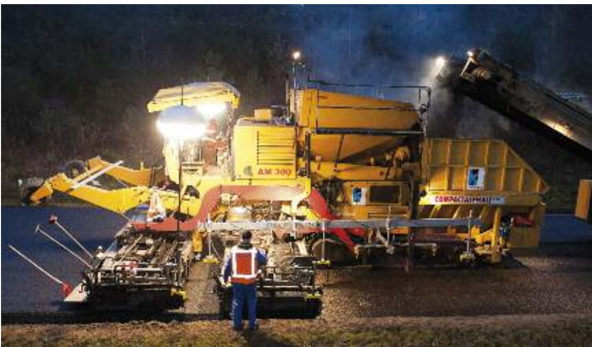
Bild 10: Einbau auf Untersuchungsstrecke B16 Unterhausen
