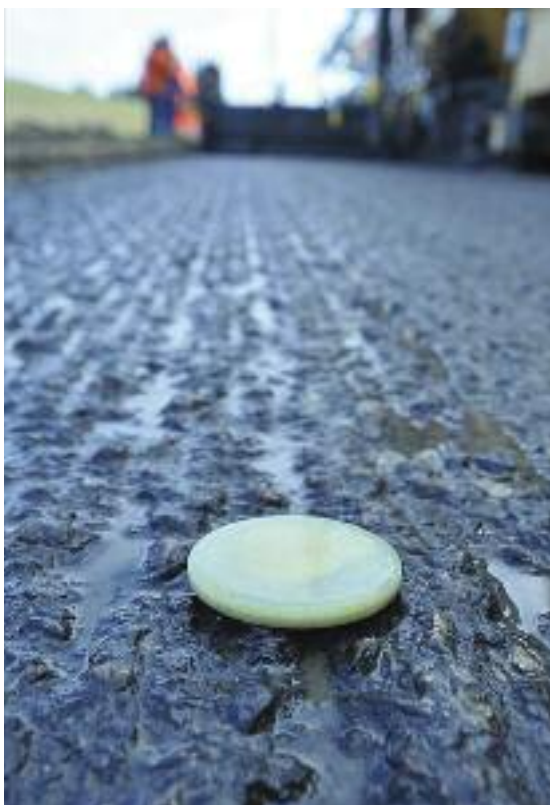
Bild 8: RFID-Transponderverlegung zur Datenspeicherung
