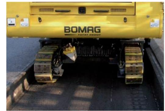
Abtragsfräsen bis zur ungebundenen Tragschicht
