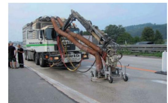
Spezialreinigen von Betonoberflächen mit Hochdruckwasser  $\geq 1000$  bar
