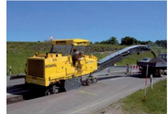
Abtragsfräsen mit Laden des Fräsgutes
