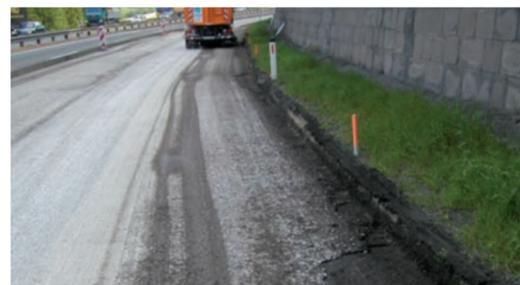
Variation der Schichtdicke der zu fräsenden Asphaltsschicht – Nachfräsen erforderlich
