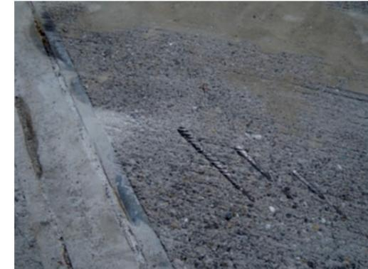
Durch Fräsen beschädigte Oberfläche des Betontragwerkes – Freigelegte Bewehrung
