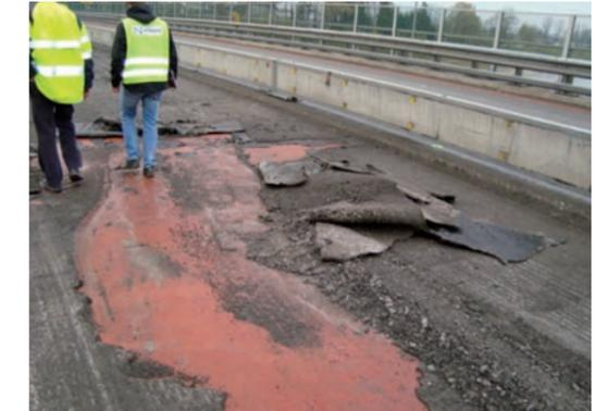
Durch Fräsen abgetragene Feuchtigkeitsabdichtung – Neuerstellung erforderlich
