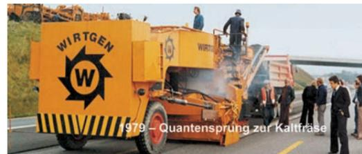
Erst die Einführung der Kaltfrästechnik hat die großflächige und tiefgreifende Instandsetzung von Asphaltkonstruktionen ermöglicht.
