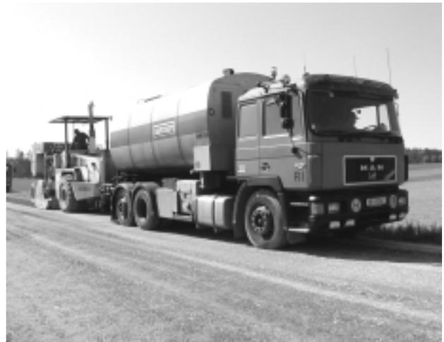
Fräse mit beheizbarem Bitumentankwagen
