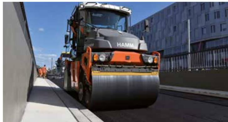
Die Trag- und Binderschicht im Tunnel wurde unter anderem von der Kombiwalze DV+ 90i VT-S mit thermischen Schürzen durchgeführt.
