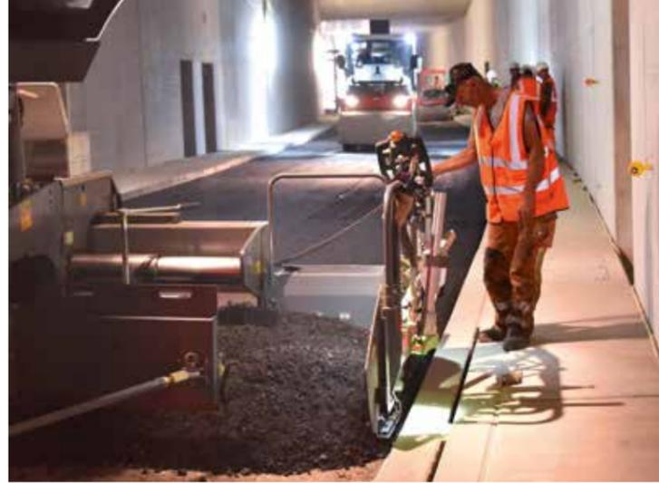
Herausforderung Niedrigtemperaturasphalt: Mit Maschinen von Vögele und Hamm erstellte das ausführende Unternehmen im Karlsruher Autotunnel eine hochwertige und homogen verdichtete Fahrbahn.
