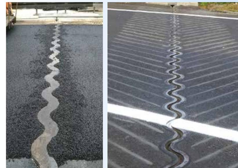
Abbildung 5: Best-Practice Beispiel mit Ausführung eines Gußasphaltstreifens als Tragschicht mit
