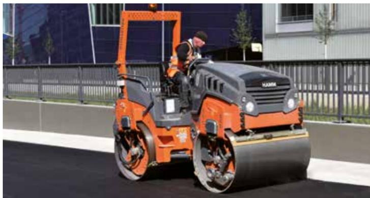
Bei der Endverdichtung kam dann auch die Hamm Kompaktwalze HD 14i VO mit einer Vibrations- und einer Oszillationsbandage zum Einsatz.
