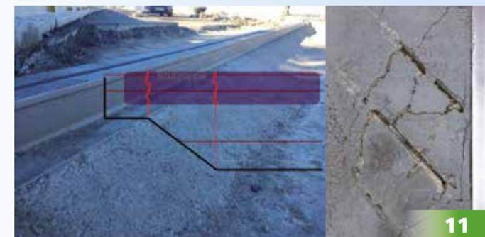
Abbildung 4: Stützrippenbruch durch sprunghafte Änderung der Belagsanschlusshöhe
