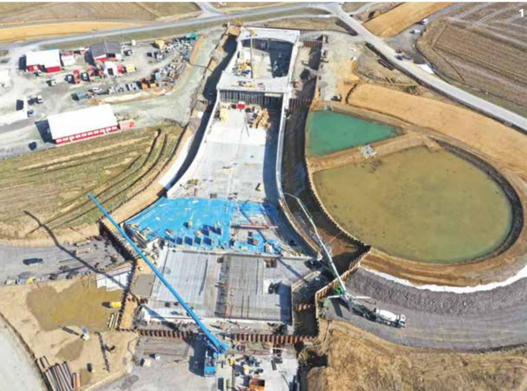
**1** Im Zuge der Anschlussstelle Rudersdorf wird das Wannensbauwerk mit optimiertem Weiße Wanne Beton errichtet.
