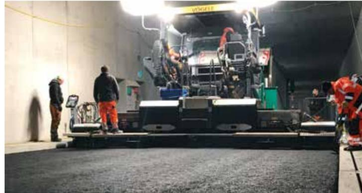
Mit den Ausziehbohlen AB 500 und AB 600 von Vögele konnten die Fertiger eine hohe Vorverdichtung erzielen und damit die Anzahl der erforderlichen Walzübergänge reduzieren.
