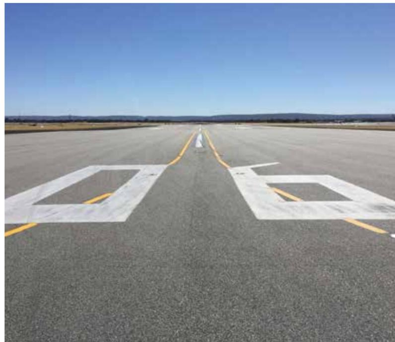
Bild 8: Zustand der Start- und Landebahn 8 Jahre nach der Sanierung (2017)
