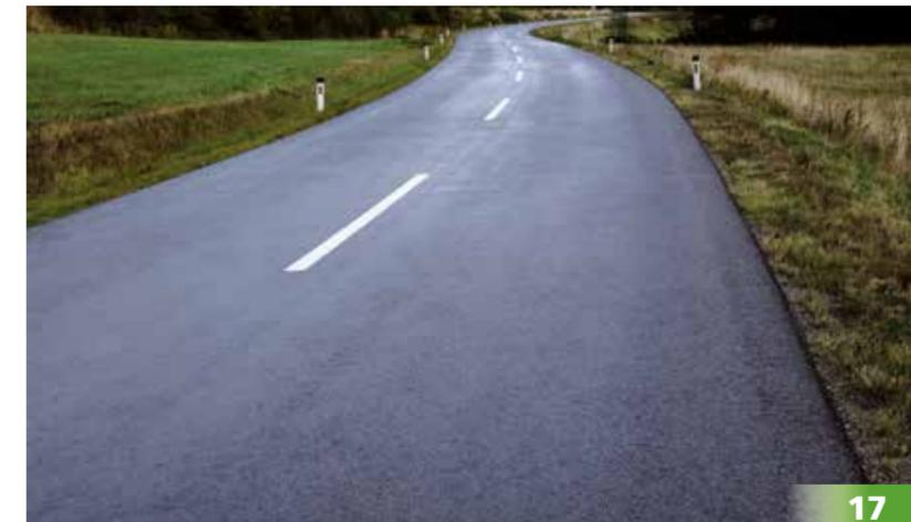
Bild 5: Zustand der Raidinger Straße 7 Jahre nach der Sanierung (2015)
