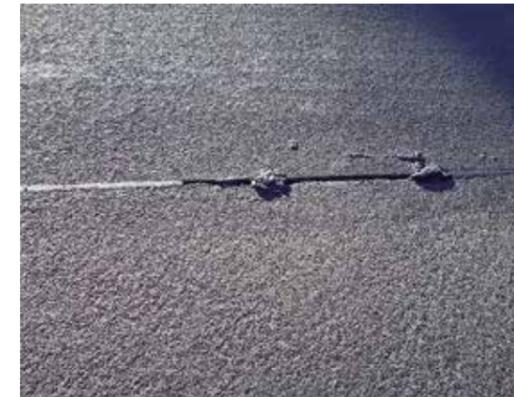
Abbildung 4: Eine in der Rollspur angeordnete schadhafte Fuge mit Heißvergussmasse (linkes Bild) und eine mit aus den Fugen rausgezogene Heißvergussmasse verschmutzte Fahrbahnoberfläche auf einer Bundesautobahn (rechtes Bild)
