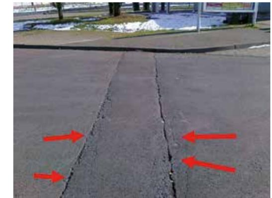
Abbildung 2: Fehlende Fugenausbildung an einer Entwässerungseinrichtung im Asphaltkörper (linkes Bild) und bereits stark geschädigte Aufgrabung an den Anschlussstellen aufgrund fehlender Fugenausbildung (rechtes Bild)
