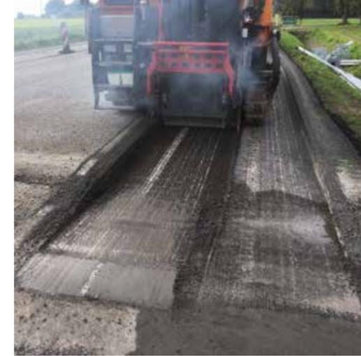
Bild 9: Fräsen der Asphaltschicht inklusive Asphaltbewehrung
