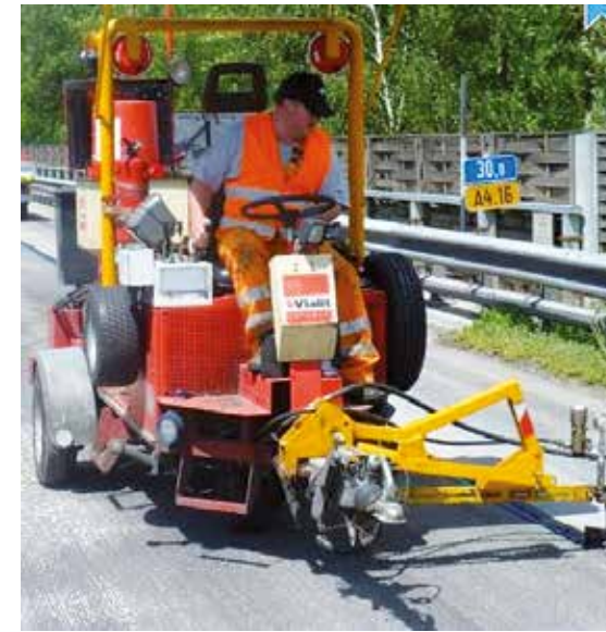
Replast maschinell ( Maschinelle Beschichtung )
