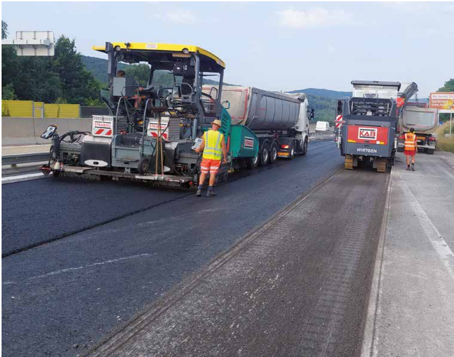
Abbildung 1: Abtrag und Einbau im gleichen Baulos
