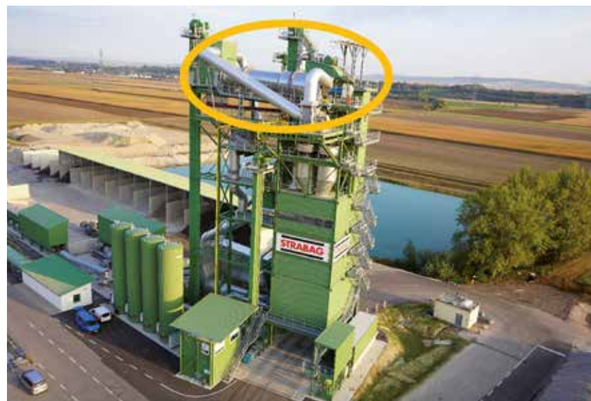
Abbildung 8: Asphaltmischanlage der STRABAG in Hausleiten /NÖ im Tullnerfeld
