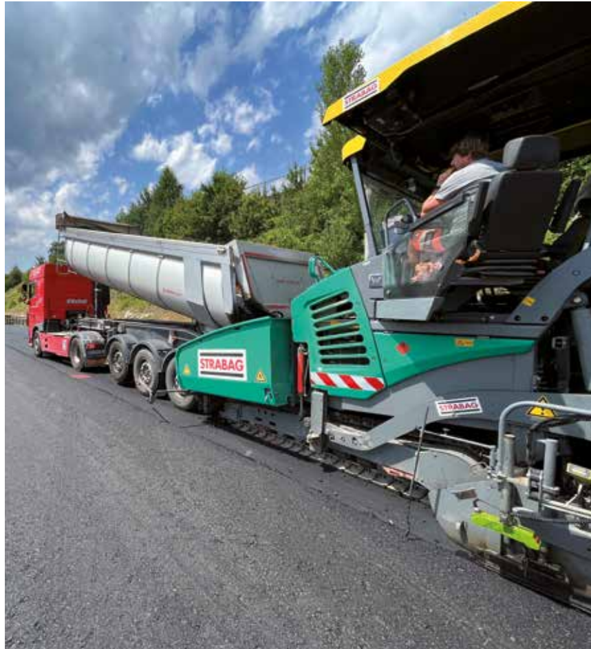
Abbildung 4: Einbau Binderschicht
