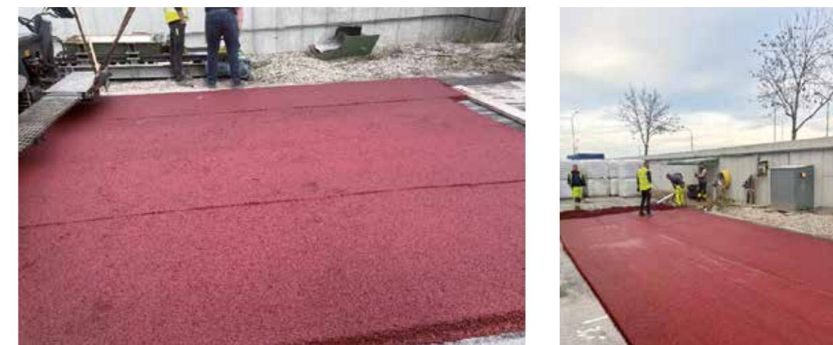
Abb. 7: Einbau Probestrecke - Großtechnische Umsetzung und weitere Optimierung im Zuge der Herstellung einer Probefläche
