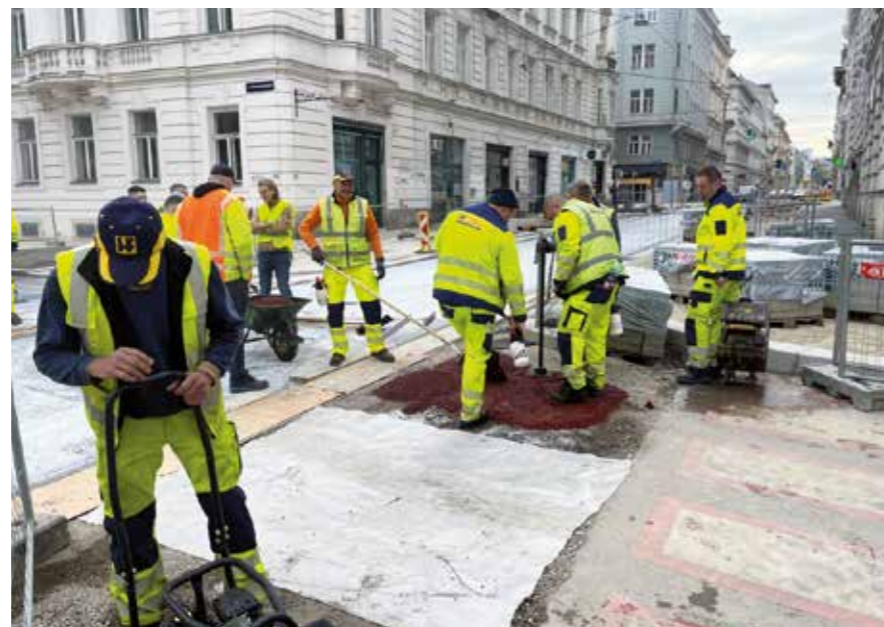
Abb. 10+11: Überprüfung der Einbautemperatur und Schutz der Asphaltdecke vor Verunreinigungen (Quelle: Held & Francke)
