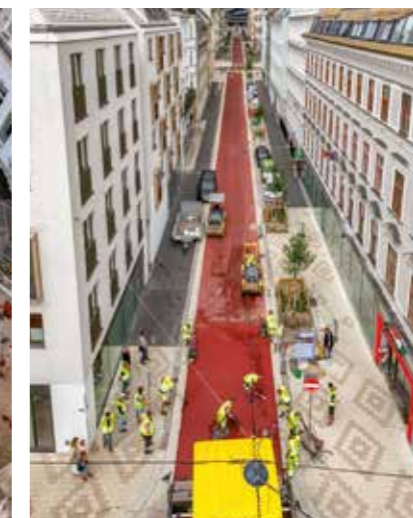
Abb. 12+13+14: Einbau und Fertigstellung der roten Asphaltdecke auf der Argentinierstraße
