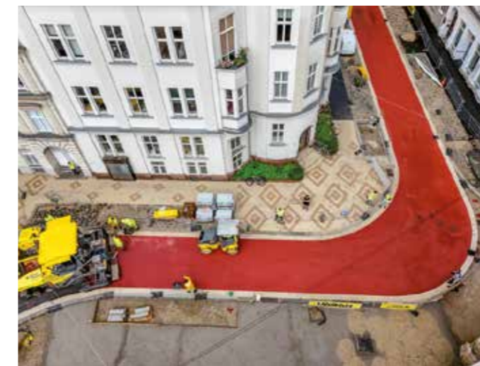
Abb. 12+13+14: Einbau und Fertigstellung der roten Asphaltdecke auf der Argentinierstraße
