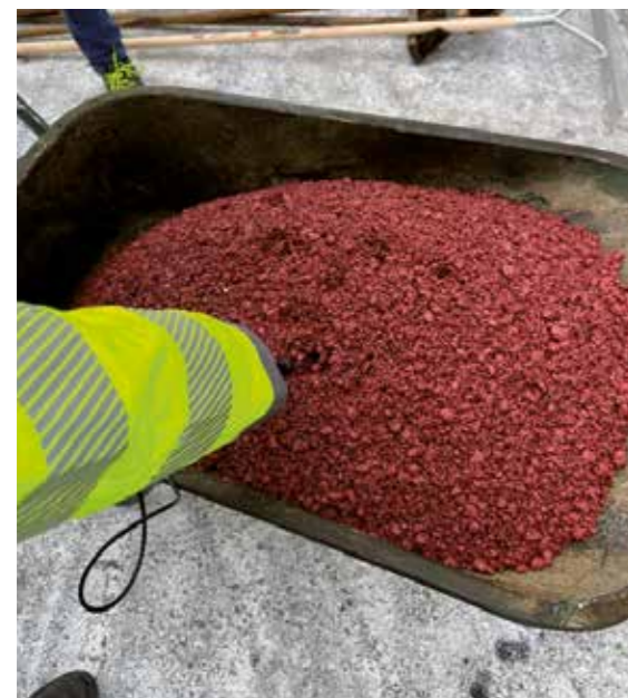
Abb. 10+11: Überprüfung der Einbautemperatur und Schutz der Asphaltdecke vor Verunreinigungen (Quelle: Held & Francke)
