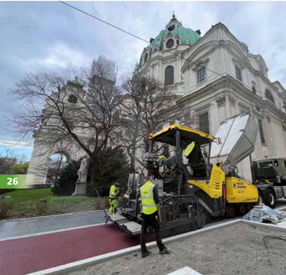
Abb. 8 und 9: Einbau des roten Asphaltbelages bei der Karlskirche – 1. Bauphase
