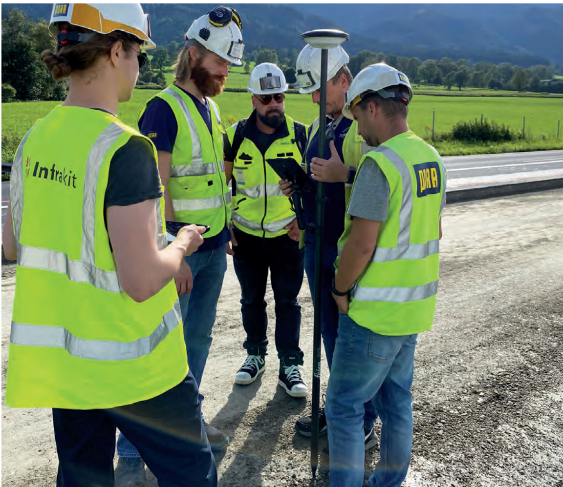
Abb 2: Einsatz der digitalen Aufmaßerstellung im Baufeld
