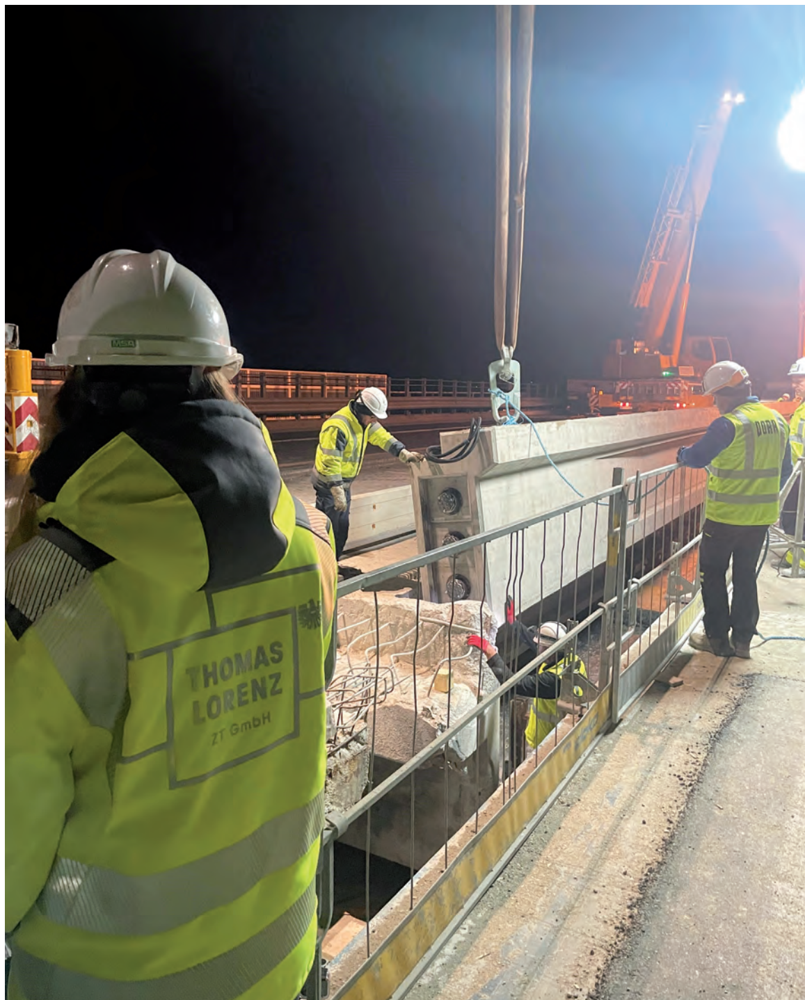
Abb 1: Einheben eines vorgespannten Fertigteilträgers
