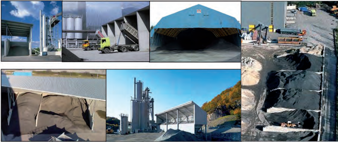
Überdachungen der Materialboxen und Lagerhallen für RA Material haben einen geringeren Brennstoffverbrauch in der Mischanlage zur Folge
